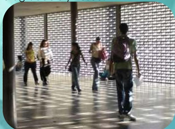
Imagen 55. Uso de muros de celosía para introducir ventilación a nuestros espacios cerrados para mantener un control de temperatura adecuado.
