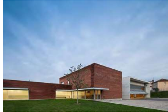
Imagen 11: Perspectiva exterior zona de camiones y área de comedor Fuente: http://www.archdaily.mx/mx/02-239308/estacion-de-bomberos-de-santo-tirso-alvaro-siza
