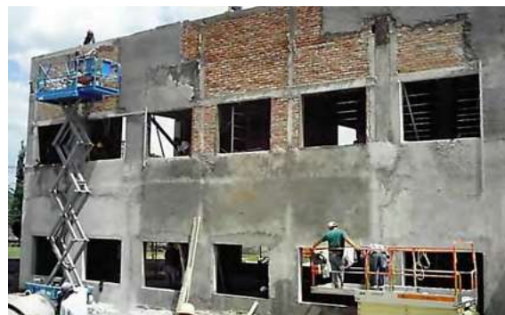
Imagen 76: Muro de tabique Rojo Recocido Fuente: http://www.aguascalientes.gob.mx/transparencia/calidad/sop/obras/ReportesVarios/masgrande.asp?Foto=imagen.asp?id=13414
