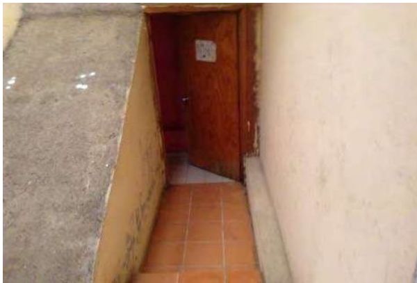
Imagen 33: Estación de bomberos de Puruándiro- baños mujeres Fuente: Foto tomada por Eduardo Aguilera
