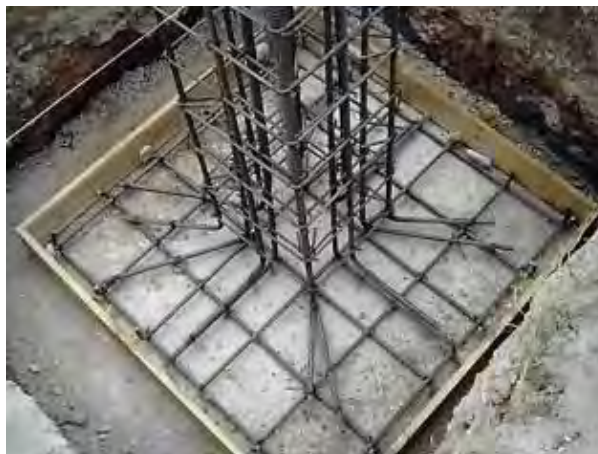
Imagen 73: Zapata aislada de concreto armado Fuente: http://casarinacopronto.com.br/exibir_paginas.php?id=102
