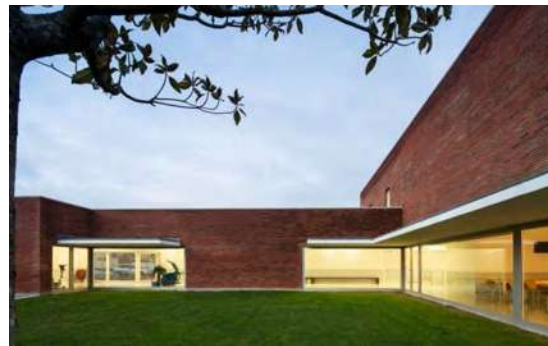
Imagen 12: Perspectiva exterior zona de comedor y circulación Fuente: http://www.archdaily.mx/mx/02-239308/estacion-de-bomberos-de-santo-tirso-alvaro-siza
