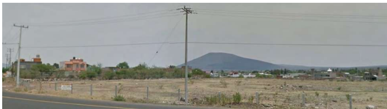
Imagen 45: Localización del servicio de electricidad para el terreno Fuente: Foto tomada por EAA (ver plano de localización de servicios)
