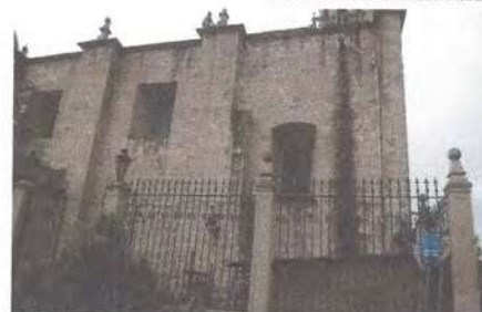
Limpeza en cornisas y muros
