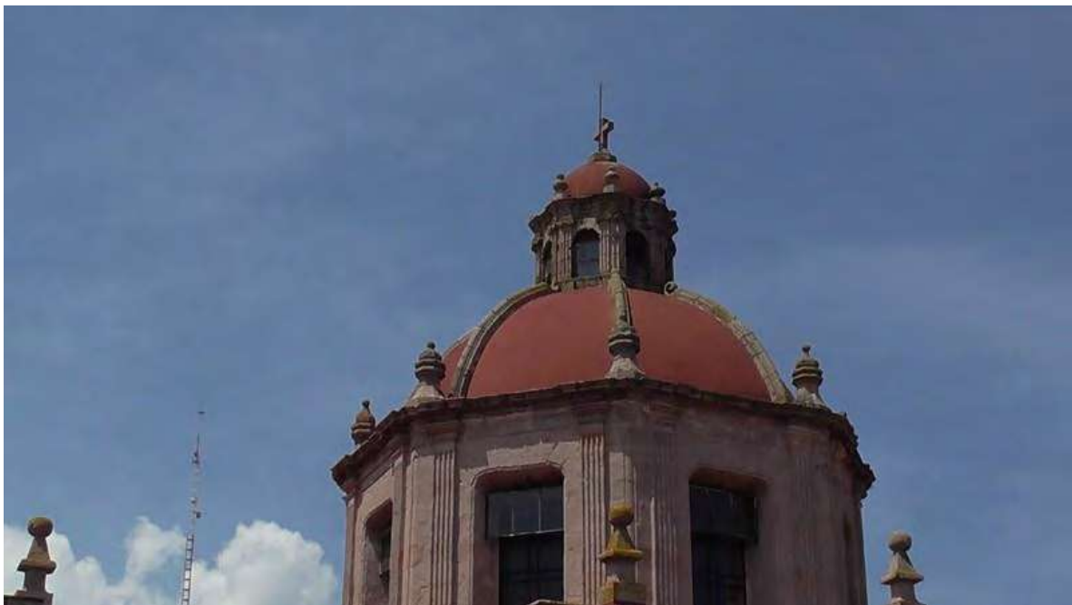
Imagen.24.-Levantamiento y reconocimiento de los trabajos a realizar. Fachad del Santuario de la Virgen de Guadalupe. (San Diego). Tomada por CIVP.
