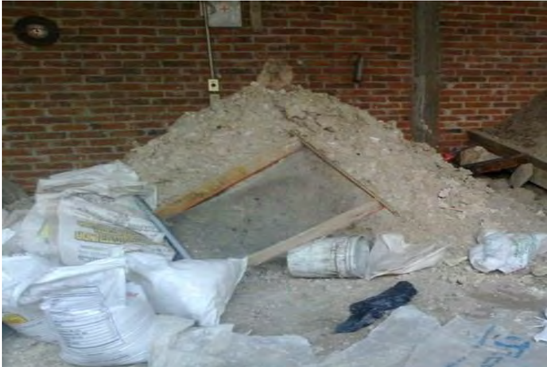
Imagen.37.- Cal- Hidra, apagada para el uso de los trabajos a realizar. Fechad del Santuario de la Virgen de Guadalupe... (San Diego). Tomada por CIVP.
