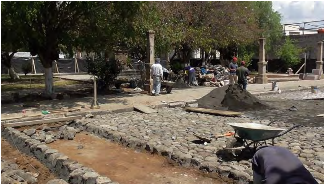
Imagen.19.- Fechad del Santuario de la Virgen de Guadalupe. (San Diego).construcción de tapial y calle restauración. Titulo.- Cesar Iván Villegas Pintor
