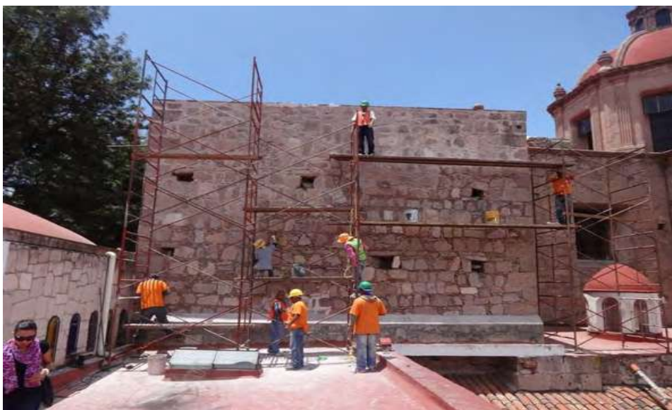
Imagen.24.-Suministro de equipo para la limpieza y mano de obra califica para los trabajos a realizar. Fachad del Santuario de la Viraen de Guadalupe. (San Dieaq). Tomada por CIVP.
