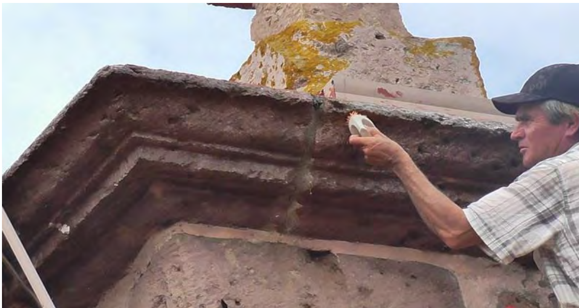
Imagen.28.- Limpieza y mano de obra califica para los trabajos a realizar. Fechad del Santuario de la Virgen de Guadalupe. (San Diego). Tomada por CIVP.
