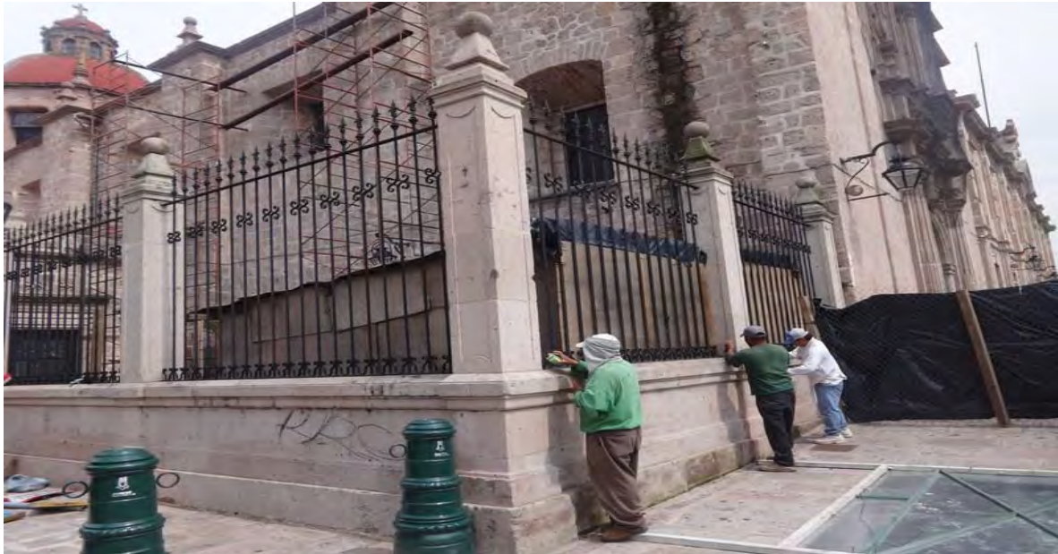
Imagen.68.-Limpieza de Herrería y pintura para realiza los trabajos. Fechad del Santuario de la Virgen de Guadalupe. (San Diego). Tomada por CIVP.
