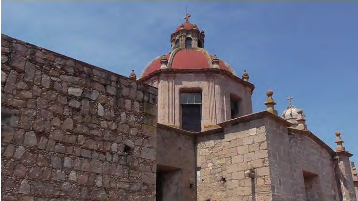
Imagen.23.-Levantamiento y reconocimiento de los trabajos a realizar. Fachad del Santuario de la Virgen de Guadalupe. (San Diego). Tomada por CIVP.
