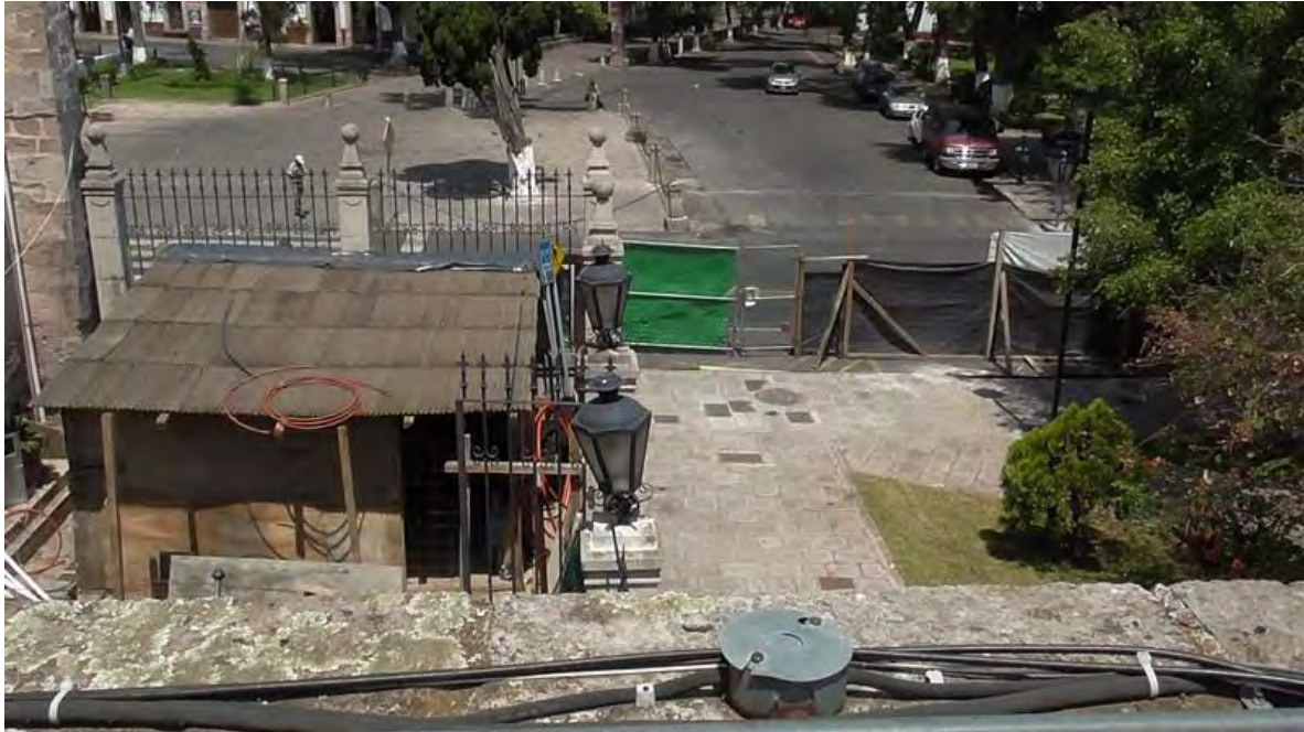
Imagen.20.- Construcción de Bodega. Fechad del Santuario de la Virgen de Guadalupe. (San Diego). Tomas por CIVP.
