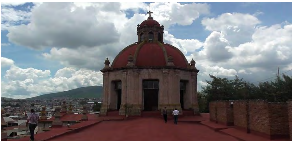
Imagen.62.-Limpieza de plantas y Consolidación de piezas para realiza los trabajos. Fechad del Santuario de la Virgen de Guadalupe. (San Diego). Tomada por CIVP.
