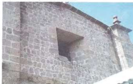
Trabajos terminados de limpieza
