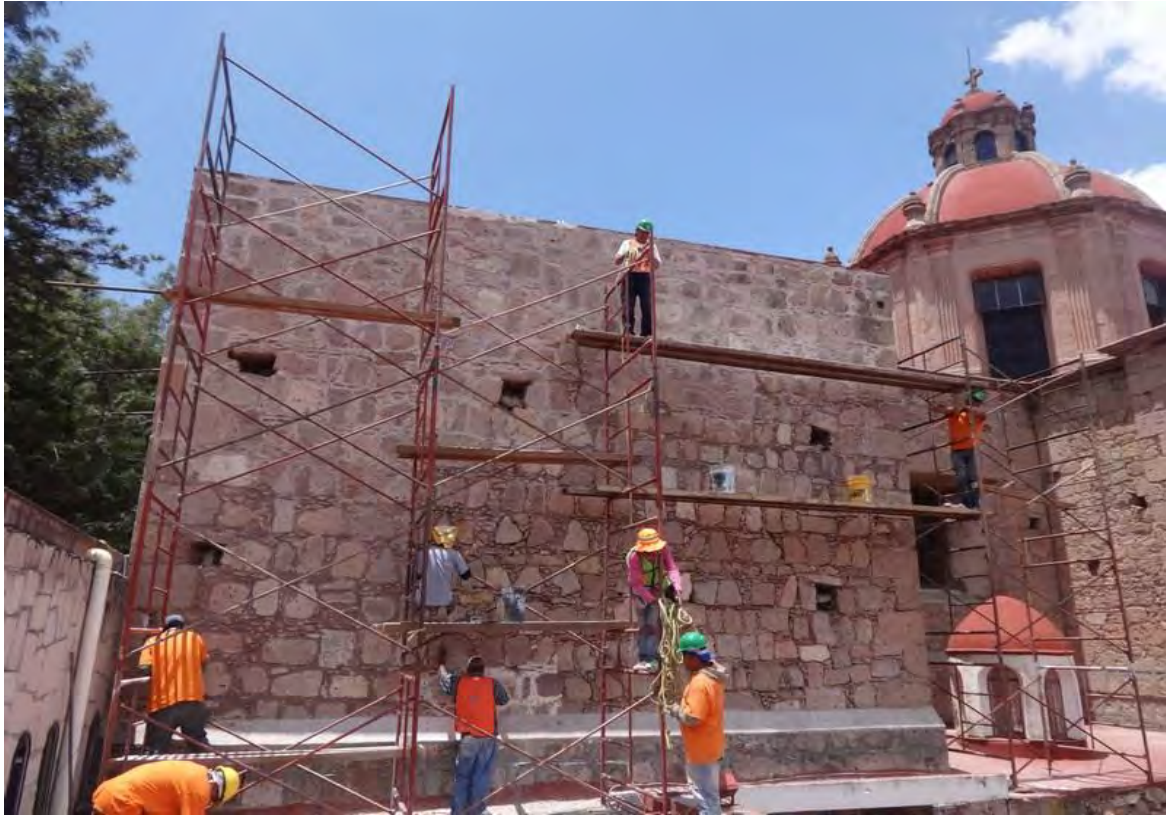
Imagen.49.-Rejunteo y Consolidación de piezas para realiza los trabajos. Fechad del Santuario de la Virgen de Guadalupe. (San Diego). Tomada por CIVP.
