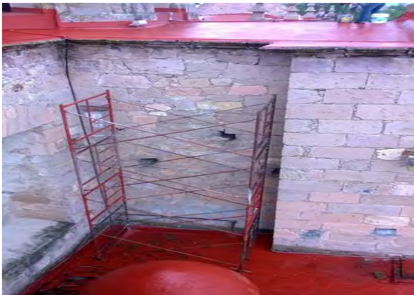
Imagen.26.- Suministro de equipo para la limpieza y mano de obra calificada para los trabajos a realizar. Fachad del Santuario de la Virgen de Guadalupe. (San Diego). Tomada por CIVP.
