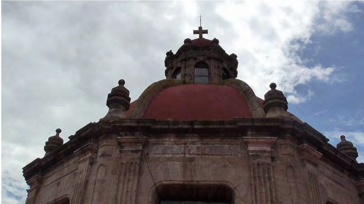
Imagen.63.-Limpieza de plantas y Consolidación de piezas para realiza los trabajos. Fechad del Santuario de la Virgen de Guadalupe. (San Diego). Tomada por CIVP.
