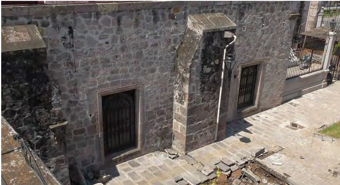
Imagen.21.-Levantamiento y reconocimiento de los trabajos a realizar. Fechad del Santuario de la Virgen de Guadalupe. (San Diego). Tomada por CIVP.
