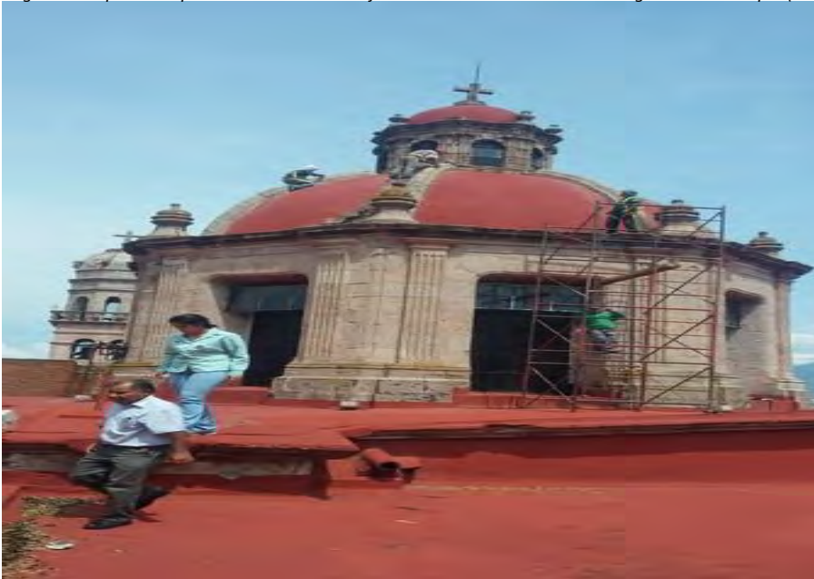
Imagen.73.-Supervision por H. Ayuntamiento de Morelia en los trabajos. Fechad del Santuario de la Virgen de Guadalupe. (San Diego). Tomada por CIVP.
