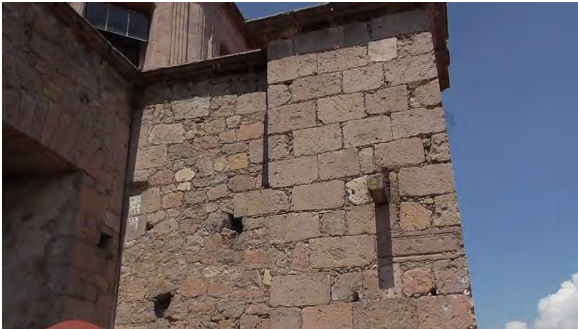
Imagen. ,48-.Rejunteo y Consolidación de piezas para realiza los trabajos. Fechad del Santuario de la Virgen de Guadalupe. (San Diego). Tomada por CIVP.
