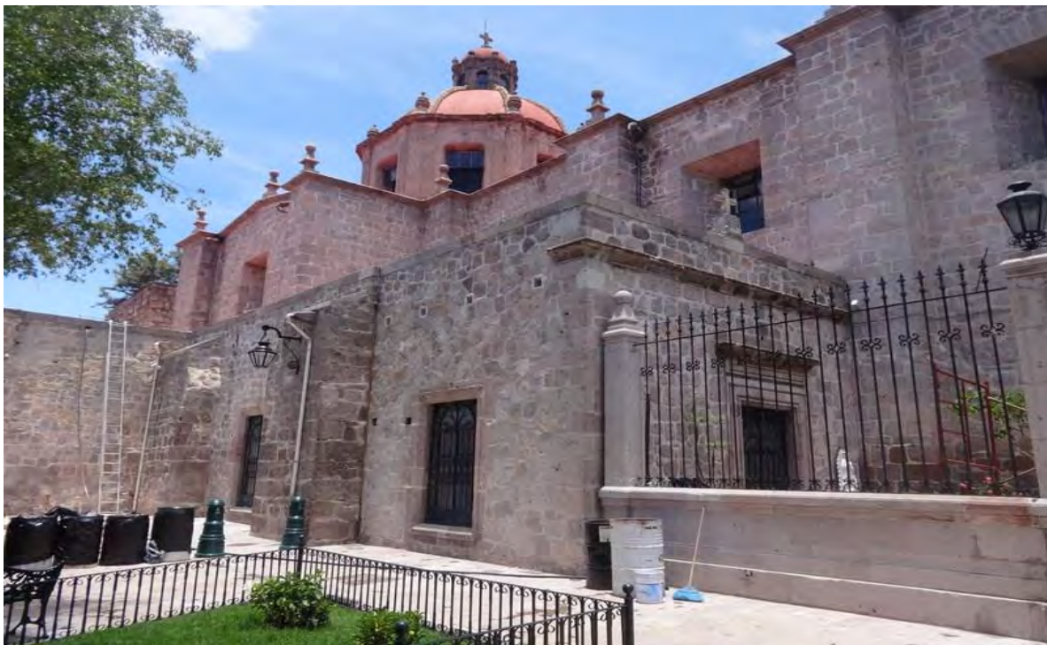
Imagen.69.-Limpieza de Herrería y pintura para realiza los trabajos. Fechad del Santuario de la Virgen de Guadalupe. (San Diego). Tomada por CIVP.
