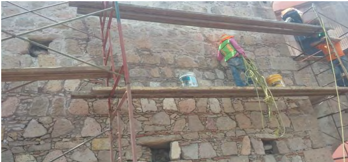
Imagen.50.-Rejunteo y Consolidación de piezas para realiza los trabajos. Fechad del Santuario de la Virgen de Guadalupe. (San Diego). Tomada por CIVP.
