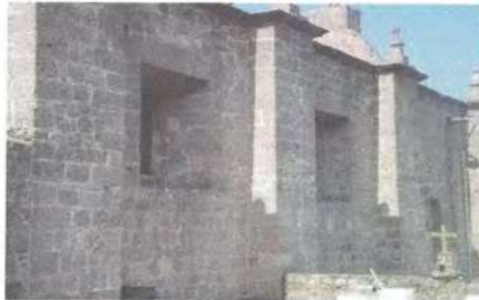
Limpieza en muros terminada
