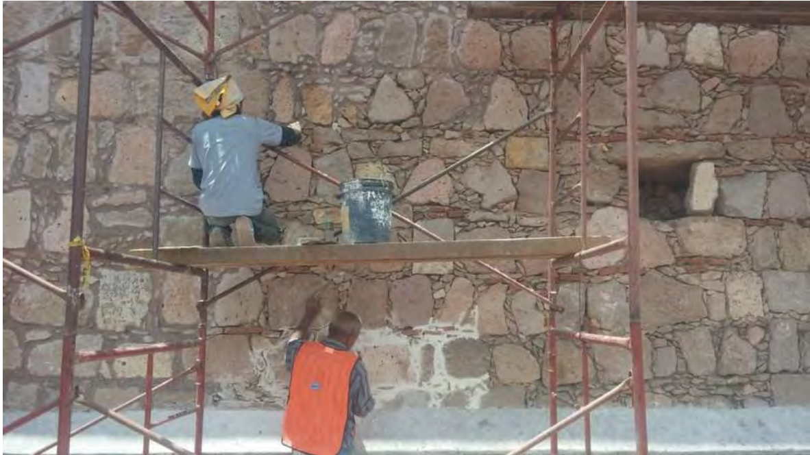
Imagen.51.-Rejunteo y Consolidación de piezas para realiza los trabajos. Fechad del Santuario de la Virgen de Guadalupe. (San Diego). Tomada por CIVP.
