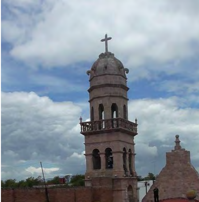
Imagen.61.-limpieza de plantas y Consolidación de piezas para realiza los trabajos. Fechad del Santuario de la Virgen de Guadalupe. (San Diego). Tomada por CIVP.
