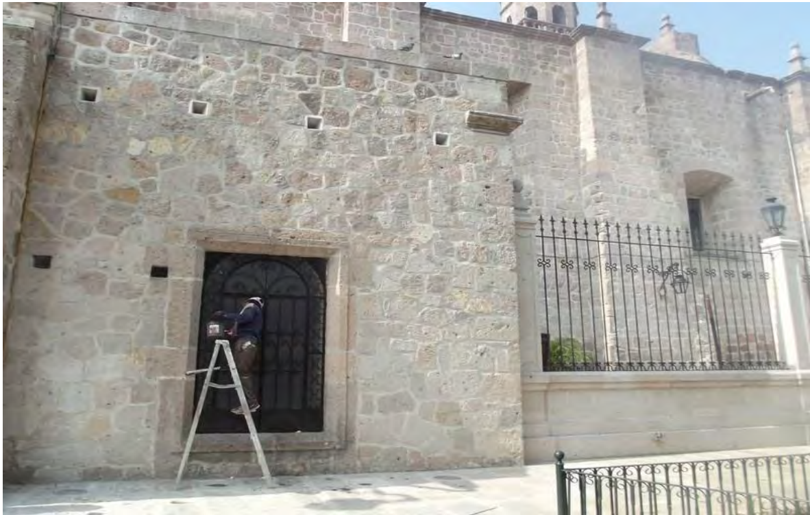
Imagen.70.-Limpieza de Herrería y pintura para realiza los trabajos. Fechad del Santuario de la Virgen de Guadalupe. (San Diego). Tomada por CIVP.
