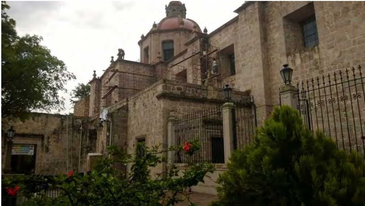
Imagen.25.- Suministro de equipo para la limpieza y mano de obra calificada para los trabajos a realizar. Fachad del Santuario de la Virgen de Guadalupe. (San Diego). Tomada por CIVP.
