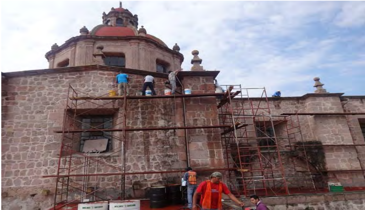
Imagen.27.- Limpieza y mano de obra califica para los trabajos a realizar. Fechad del Santuario de la Virgen de Guadalupe. (San Diego). Tomada por CIVP.
