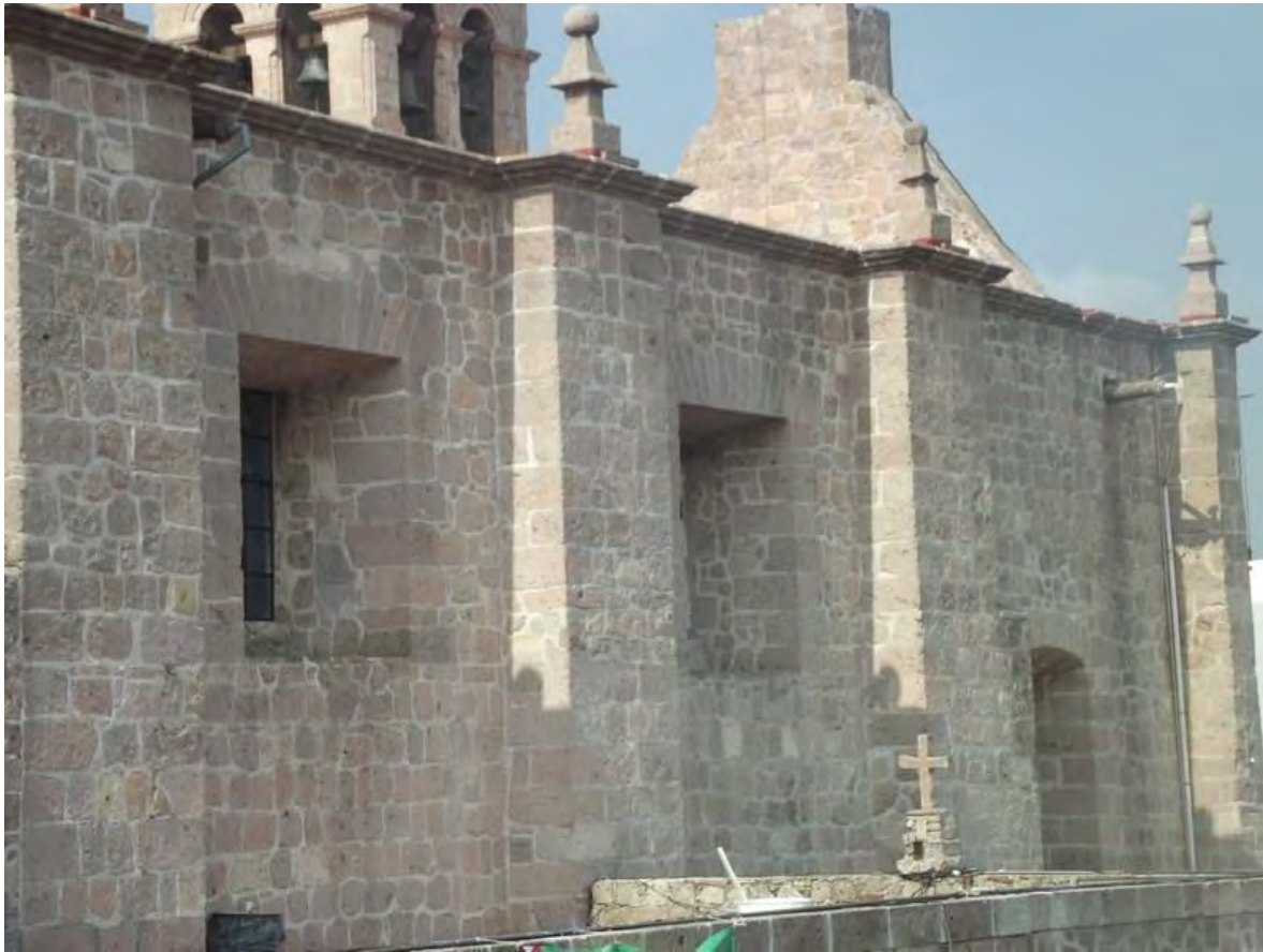
Imagen.53.-Rejunteo y Consolidación de piezas para realiza los trabajos. Fechad del Santuario de la Virgen de Guadalupe. (San Diego). Tomada por CIVP.
