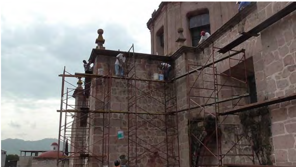
Imagen.30.- Limpieza y mano de obra califica para los trabajos a realizar. Fechad del Santuario de la Virgen de Guadalupe. (San Diego). Tomada por CIVP.
