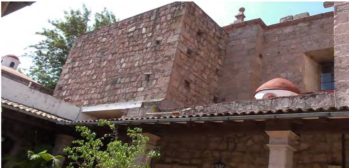
Imagen.46-.Rejunteo y Consolidación de piezas para realiza los trabajos. Fechad del Santuario de la Virgen de Guadalupe. (San Diego). Tomada por CIVP.
