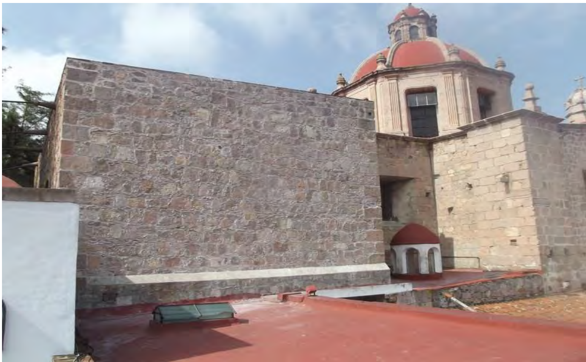
Imagen.52.-Rejunteo y Consolidación de piezas para realiza los trabajos. Fechad del Santuario de la Virgen de Guadalupe. (San Diego). Tomada por CIVP.
