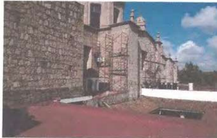
Limpezas fachada norte
