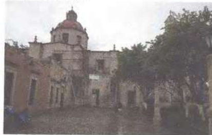
Limpieza en muros y cornisas
