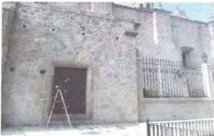
Limpieza y pintura en elementos de herrería
