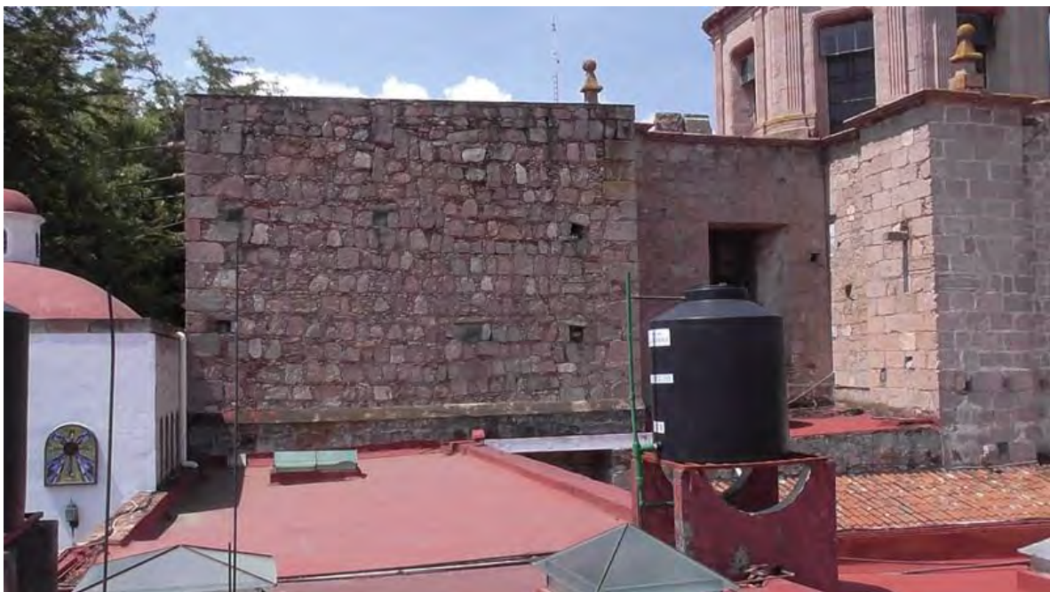
Imagen.22.-Levantamiento y reconocimiento de los trabajos a realizar. Fachad del Santuario de la Virgen de Guadalupe. (San Diego). Tomada por CIVP.
