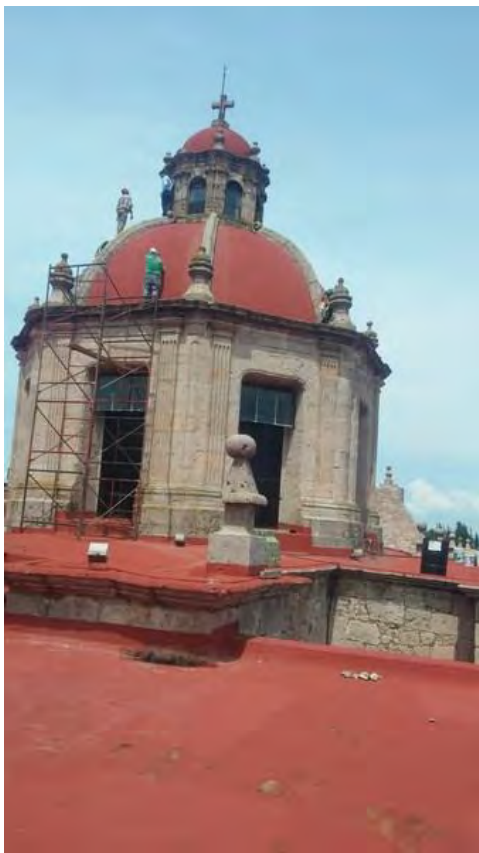
Imagen.66.-Limpieza de plantas y Consolidación de piezas para realiza los trabajos. Fechad del Santuario de la Virgen de Guadalupe. (San Diego). Tomada por CIVP.
