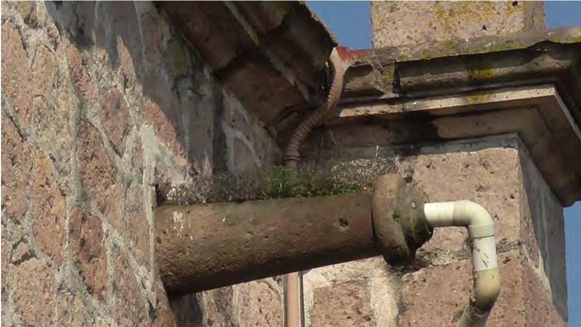
Imagen.54.-Retiro de plantas y Consolidación de piezas para realiza los trabajos. Fechad del Santuario de la Virgen de Guadalupe. (San Diego). Tomada por CIVP.
