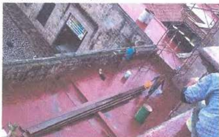
Limpieza de muros en pretil
