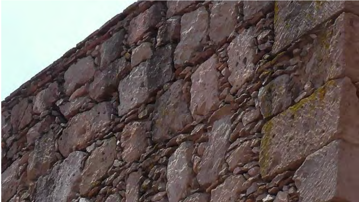
Imagen.47.-Rejunteo y Consolidación de piezas para realiza los trabajos. Fechad del Santuario de la Virgen de Guadalupe. (San Diego). Tomada por CIVP.
