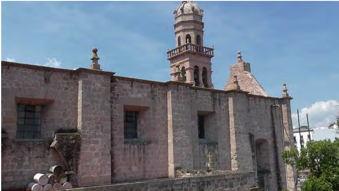
Imagen.21.-Levantamiento y reconocimiento de los trabajos a realizar. Fachad del Santuario de la Virgen de Guadalupe. (San Diego). Tomada por CIVP.
