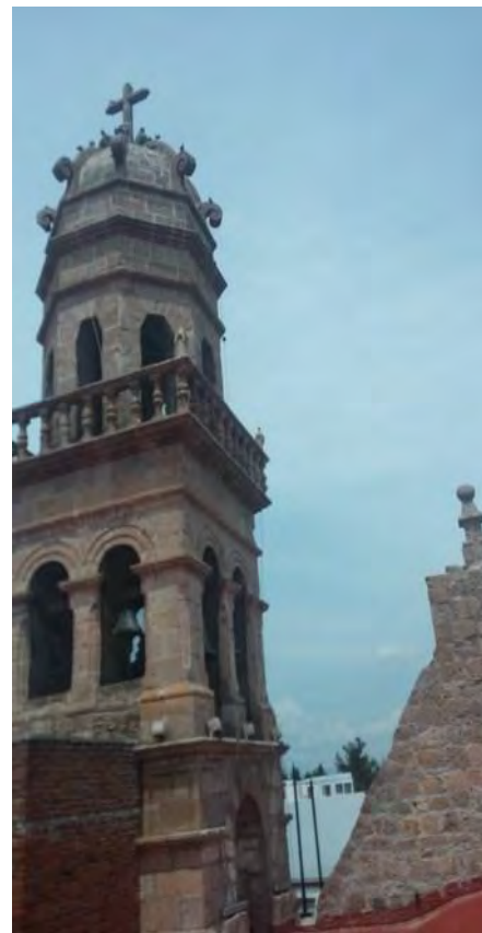
Imagen. 67.-Limpieza de plantas y Consolidación de piezas para realiza los trabajos. Fechad del Santuario de la Virgen de Guadalupe. (San Diego). Tomada por CIVP.
