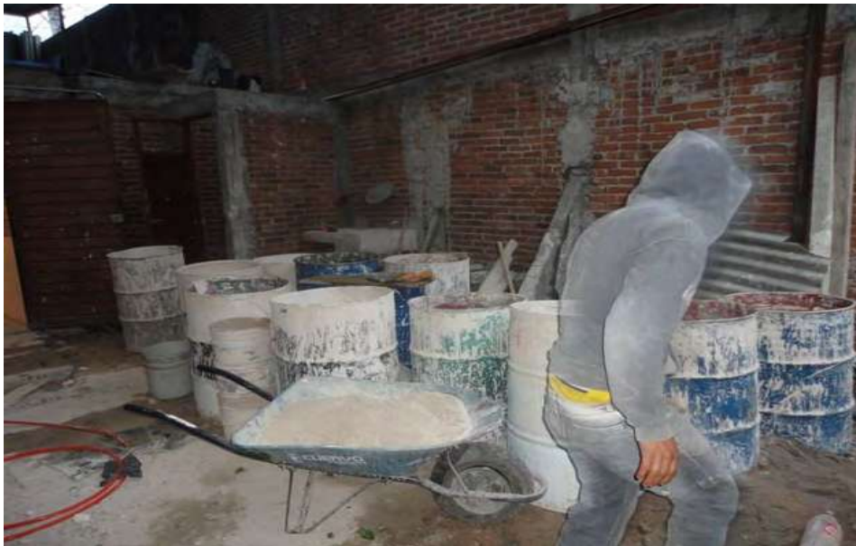
Imagen.38.-/ Cal- Hidra, apagada para el uso de los trabajos a realizar. Fechad del Santuario de la Virgen de Guadalupe. (San Diego). Tomada por CIVP.
