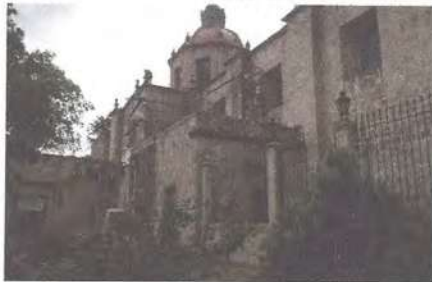
Limpeza en elementos de cantería
