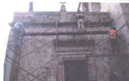
Limpeza de muro y comisa
