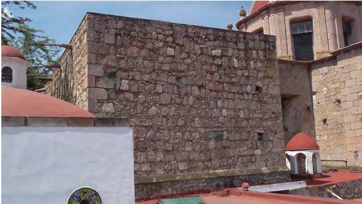
Imagen.45-.Rejunteo y Consolidación de piezas para realiza los trabajos. Fechad del Santuario de la Virgen de Guadalupe. (San Diego). Tomada por CIVP.
