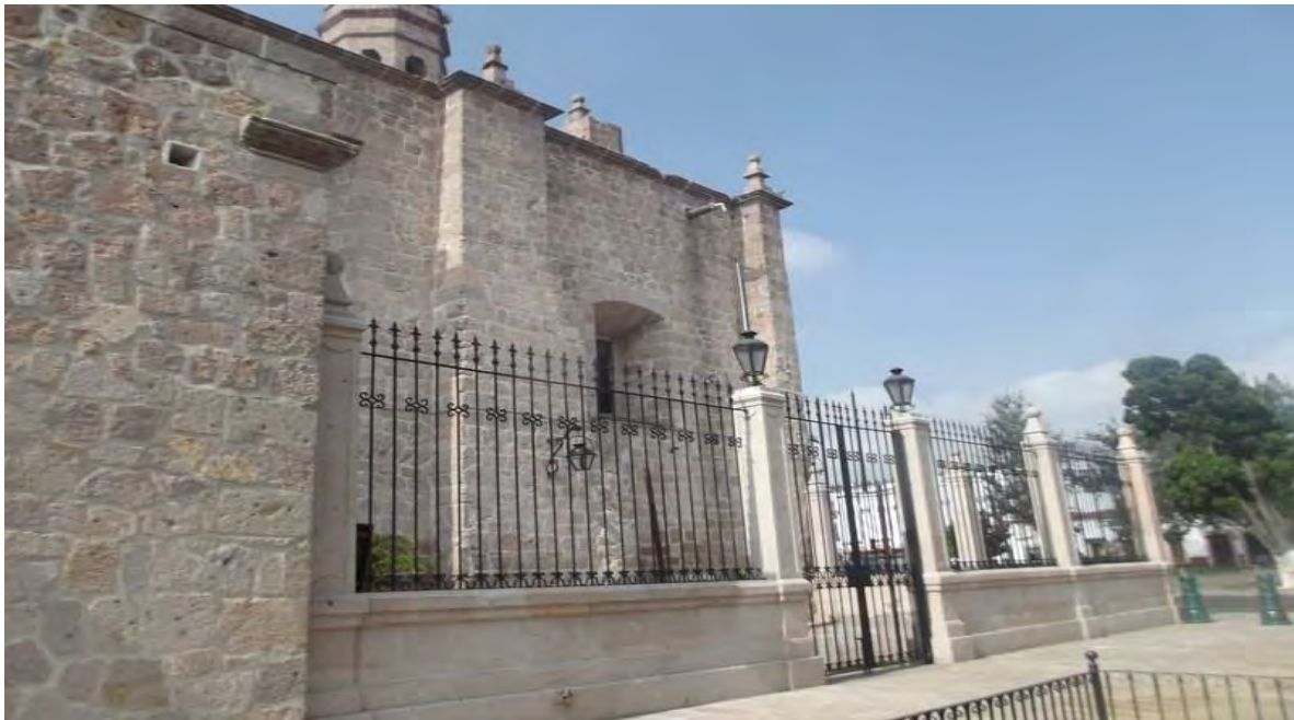
Imagen.71.-Limpieza de Herrería y pintura para realiza los trabajos. Fechad del Santuario de la Virgen de Guadalupe. (San Diego). Tomada por CIVP.
