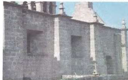
Limpieza en muro y cornisa concluida
