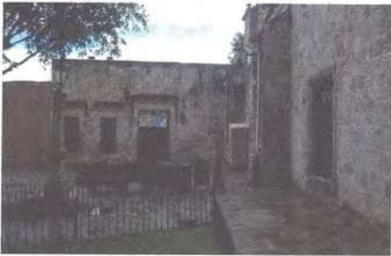
Limpeza en muro y cornisa
