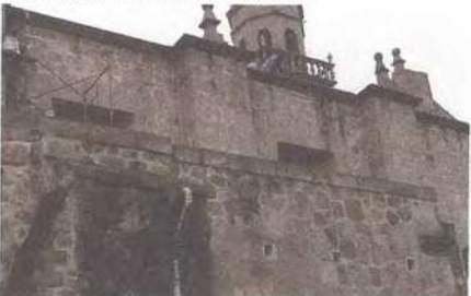
Limpieza de cornisas
