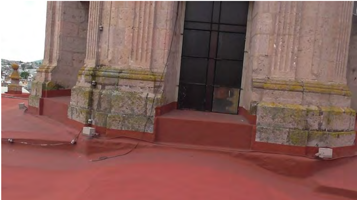
Imagen.64.-Limpieza de plantas y Consolidación de piezas para realiza los trabajos. Fechad del Santuario de la Virgen de Guadalupe. (San Diego). Tomada por CIVP.
