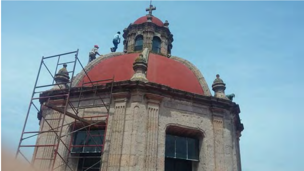
Imagen.65.-Limpieza de plantas y Consolidación de piezas para realiza los trabajos. Fechad del Santuario de la Virgen de Guadalupe. (San Diego). Tomada por CIVP.
