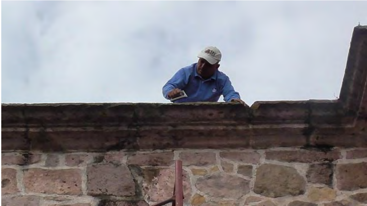
Imagen.29.- Limpieza y mano de obra califica para los trabajos a realizar. Fechad del Santuario de la Virgen de Guadalupe (San Diego). Tomada por CIVP.
