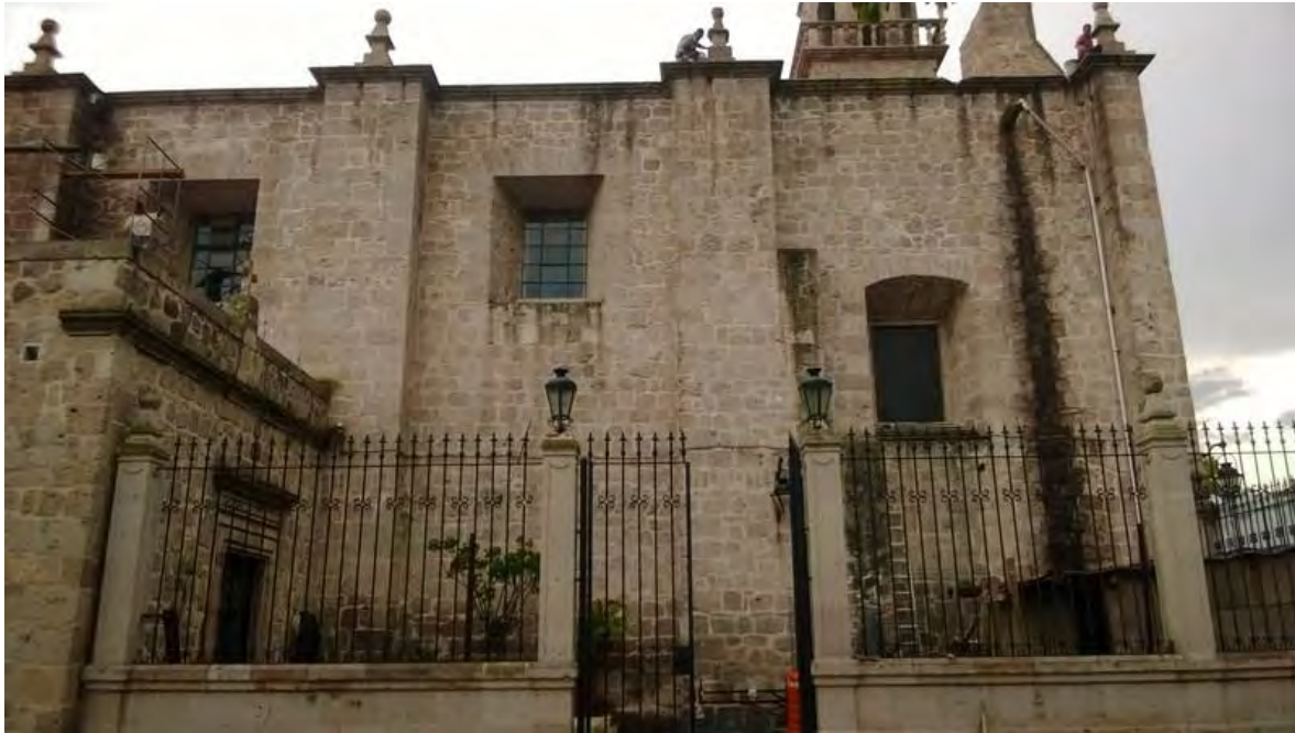
Imagen.23.-Levantamiento y reconocimiento de los trabajos a realizar. Fachad del Santuario de la Virgen de Guadalupe. (San Diego). Tomada por CIVP.
