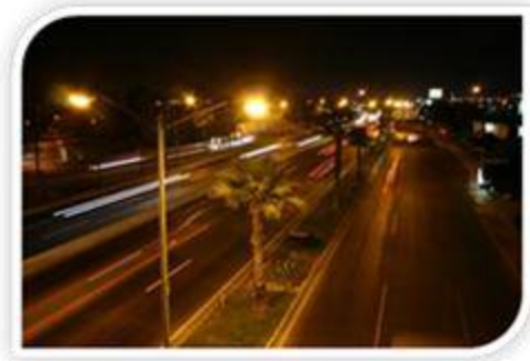
Fig. 59 Imagen de alumbrado público. Fuente: http://www.iluminet.com/alumbrado-publico/
