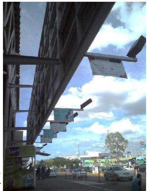
Figura 49: Estructura metálica para anuncios de un edificio de Plaza La Huerta (Vega, L., 2015).
