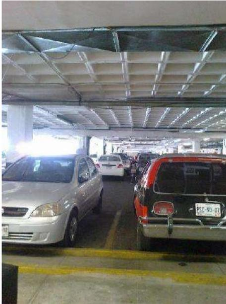
*Aquí se observa la utilización de losa reticular para soportar tanto los grandes claros y el peso que ejerce el primer nivel del edificio.*
