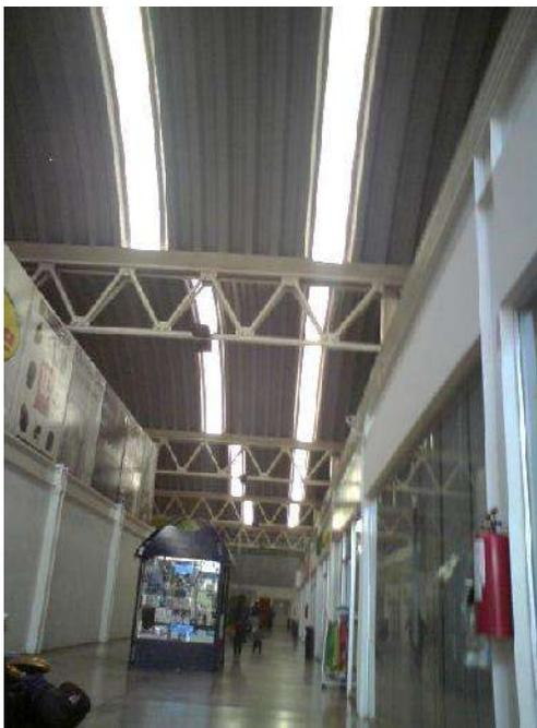
Figura 48: Cubierta de lámina de poliéster dentro de un edificio de Plaza La Huerta (Vega, L., 2015).
