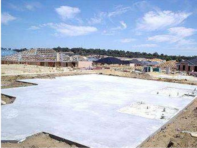
Estas cimentaciones se construyen en concreto armado preparado para reducir los posibles asentamientos. Esta estructura responde en forma óptima en suelos con estratos sensiblemente homogéneos y cuando el edificio reparte los esfuerzos sobre la losa con una retícula que guarda simetría geométrica.
