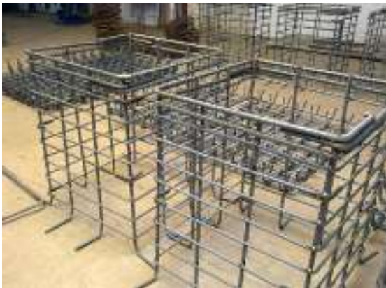
Fig. 5.6 Armado de un dado. Tomada de http://ferroval.blogspot.mx/2012/08/zapatas-para-naves-prefabricadas.html . Octubre2015
