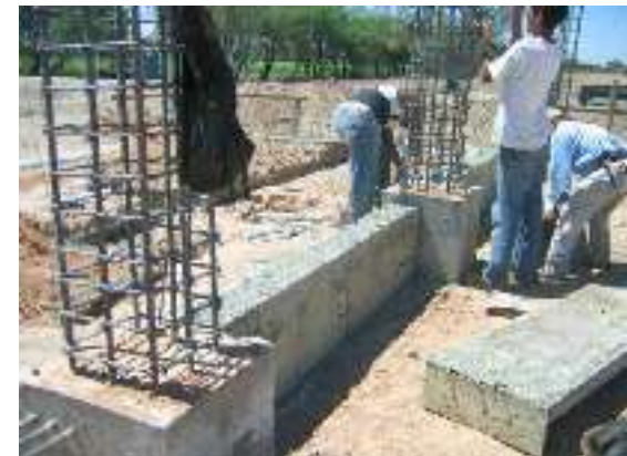
Fig. 5.8 Cimentación por zapatas aisladas, dados, traveses de liga y armado de columna. Tomada de http://www.aguascalientes.gob.mx/transparencia/calidad/sop/Obras/ReportesVarios/fotostransp.asp?StrIdContrato=4625 . Octubre2015
