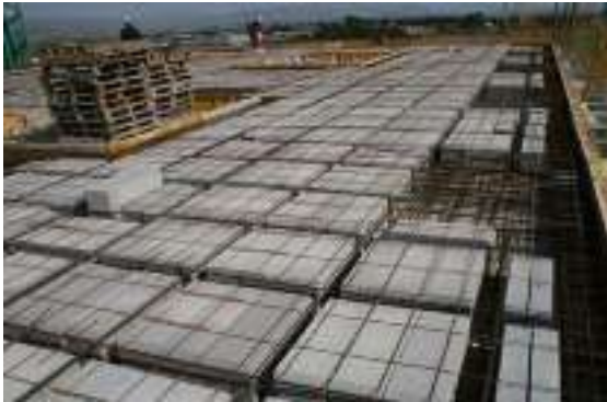
Fig. 5.18 Sistema de Losa reticular. Armado de capa de compresión. Tomada de http://www.lavirtu.com/albumes.asp?idcategoria=63986 . Octubre 2015.
