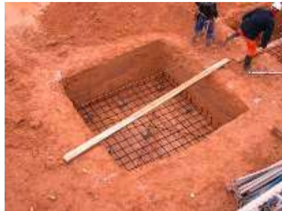
Fig. 5.7 Armado de parrilla para zapata. Tomada de http://www.panoplia.net/cimientos.htm Octubre2015
