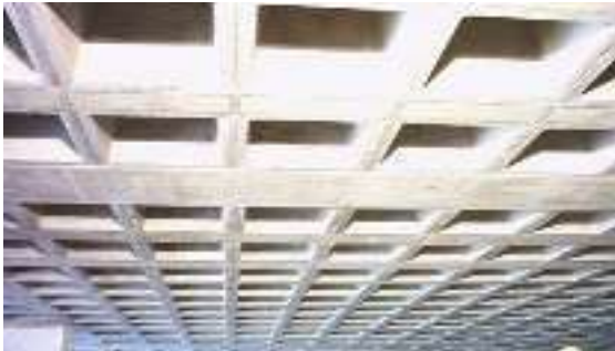
Fig. 5.19 Losa reticular sin casetón. Tomada de http://www.urbipedia.org/index.php?title=Archivo:LOSA_RETICULAR.jpg . Octubre 2015
