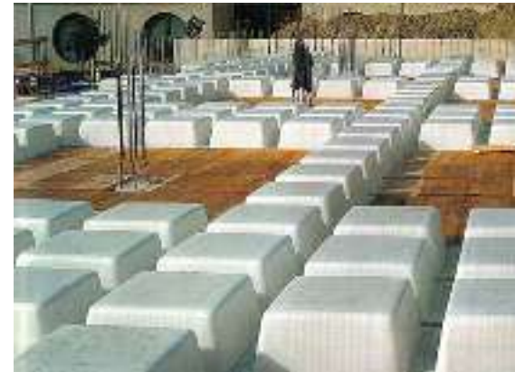
Fig. 5.16 Colocación de casetones. Tomada de http://www.construmatica.com/construpedia/Encofrados_Reticulares_para_Forjados_Bidireccionales_con_Caset%C3%B3n_Recuperable . Octubre 2015
