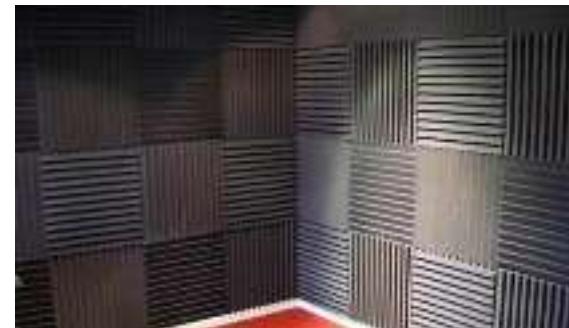
Fig. 5.25 Espuma de poliuretano en cabina master. Tomada de http://www.taringa.net/posts/info/18228791/Aislante-acustico-con-cajas-de-huevo.html . Octubre 2015
