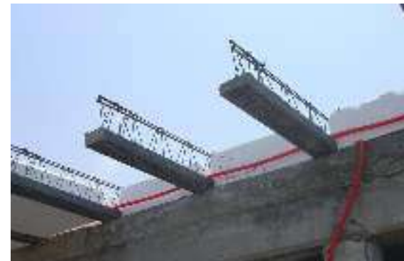
Fig. 5.17 Colocación de armado de viguetas. Tomada de http://precolar.com/ . Octubre 2015
