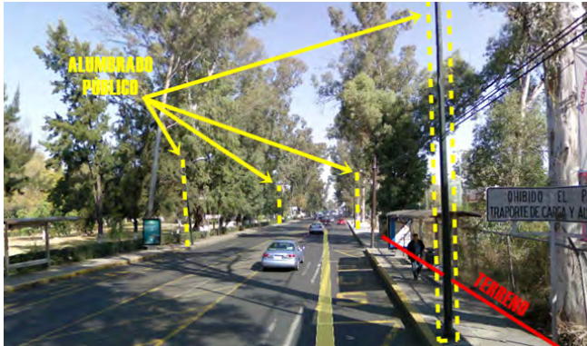
Imagen 65. Aluminado público sobre Av. Ventura Puente. Fotografía extraída de Google Earth y editada por el autor. [Consulta: 8 Noviembre 2013]
