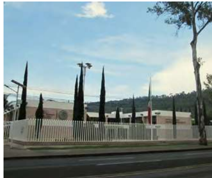
Imagen 71. Instalaciones de la Comisión Federal de Electricidad. López González, Andrea. 2015. Morelia, Michoacán. [Fotografía]
