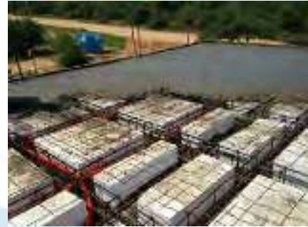
Figura 49. Colado de una losa reticular
