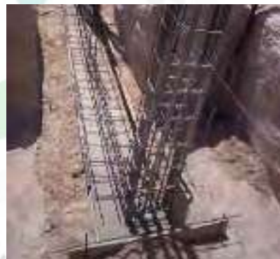
Figura 48. Zapata corrida
