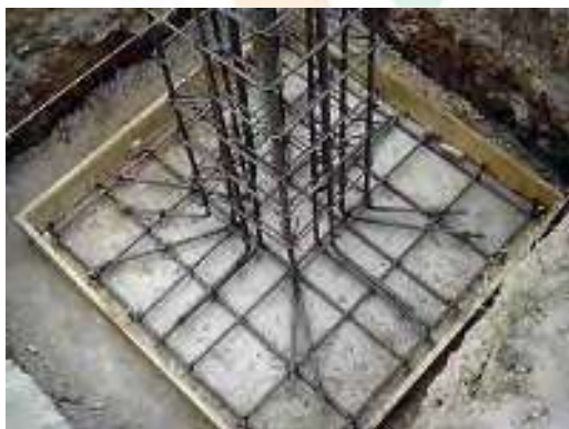
Figura 47. Zapata aislada
