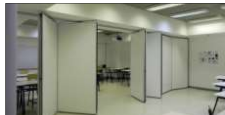
Fig. 25 Para dividir espacios de pared-a-pared paralelos. Conectados a través de bisagras 26/10/15
