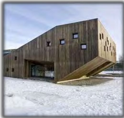
Foto #5 Instalaciones del KINDERGARTEN FAGERBORG
