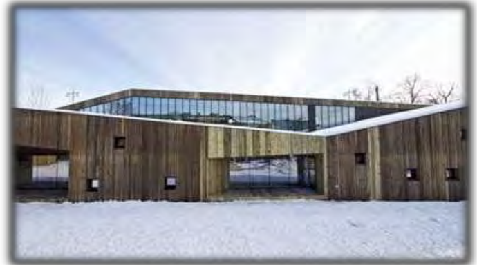
Foto #4 Instalaciones del KINDERGARTEN FAGERBORG
