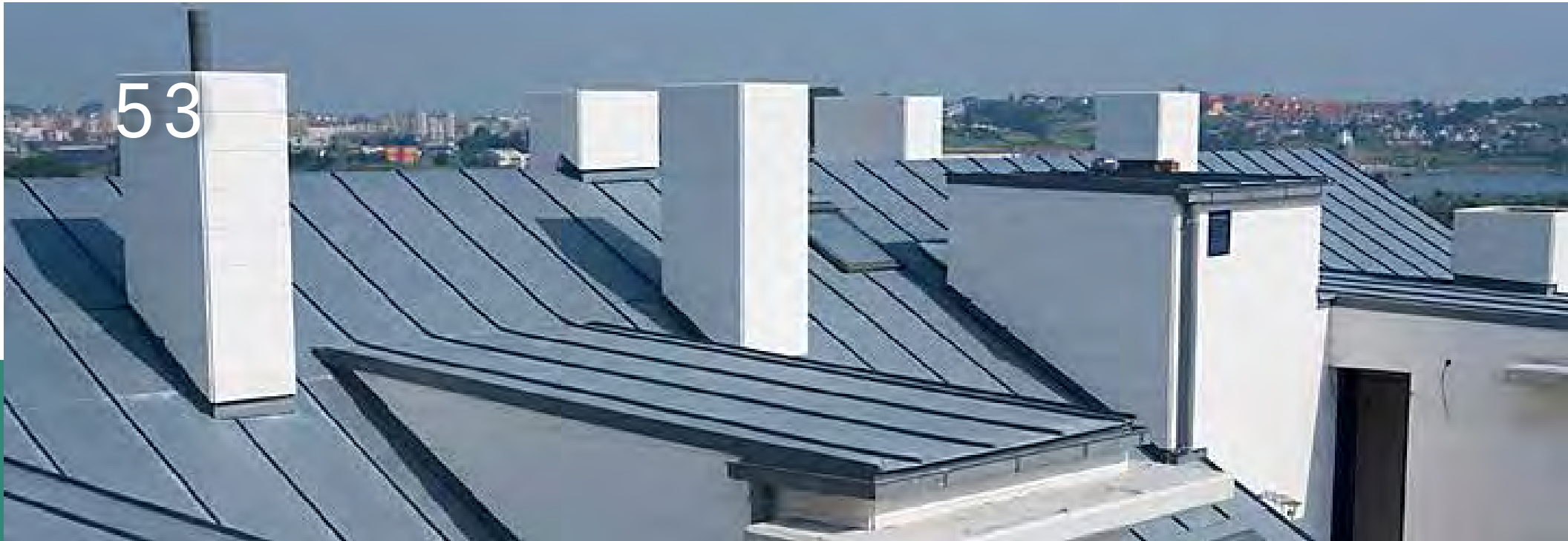
Figura 25 . Siistema de cubierta de acero de junta alzada, detalle constructivo. Imagen recuperada de:
