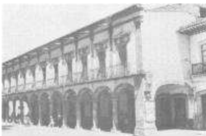
IMAGEN 123. Portal Allende de la Plaza Vasco de Quiroga, Fuente: http://dieumsnh.qfb.umich.mx/const_morepatz.htm , Diciembre 2015.
