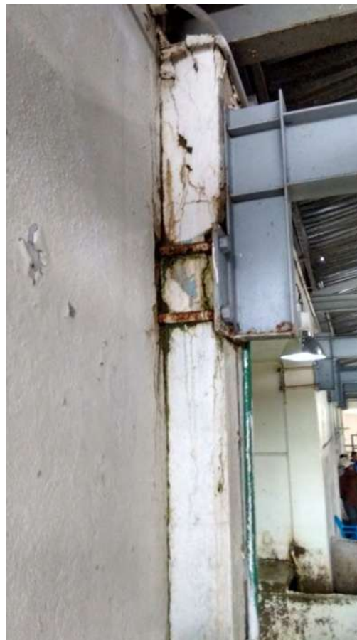
Imagen 21: Estructura presenta deterioro, debido a la oxidación, Foto: Luis Francisco Padilla Díaz
