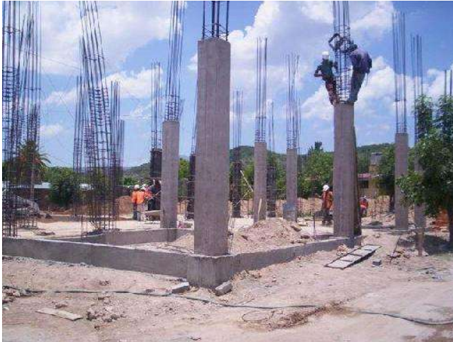
Imagen 63 Columnas de Concreto.
