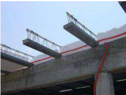
Imagen 62 vigas de concreto armado.
