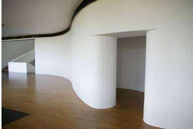
Imagen 65 Muros de Durock
