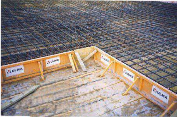
Imagen 61 losa de cimentación.
