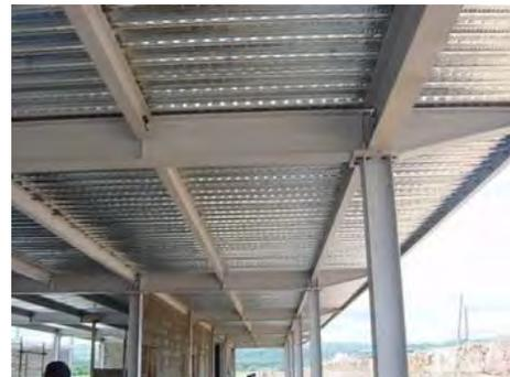
IMAGEN 30: marcos rígidos a base de estructura metálica.
