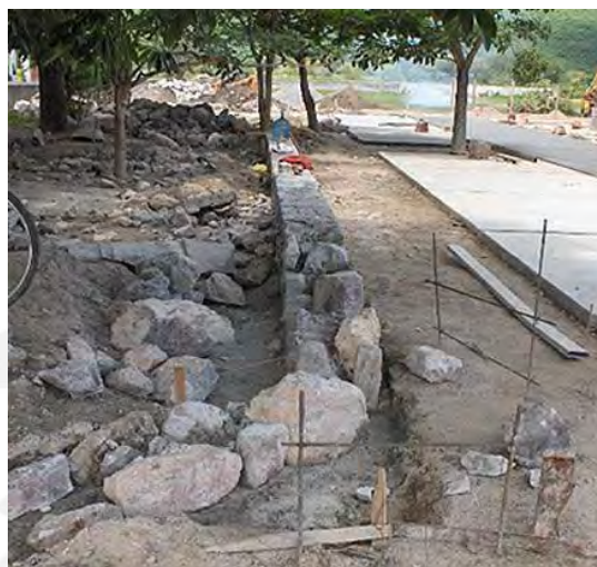
FiguraVI.10: cimiento de piedra braza [FUENTE: http://www.mailxmail.com/cursos-rocas-tipos-ciclo/costos-materiales-construccion . [Fecha De Consulta: Oct/015]
