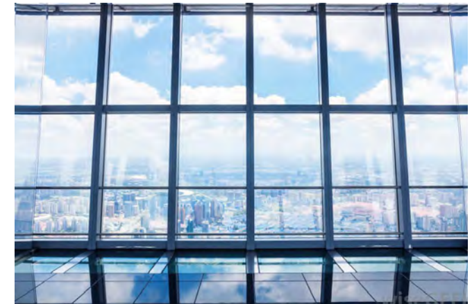
Fig 1.75 Vidrio templado y acero colocación en ventanales. Disponible en http://images.wisegeek.com/spandrel-glass-interior.jpg Enero de 2016.
