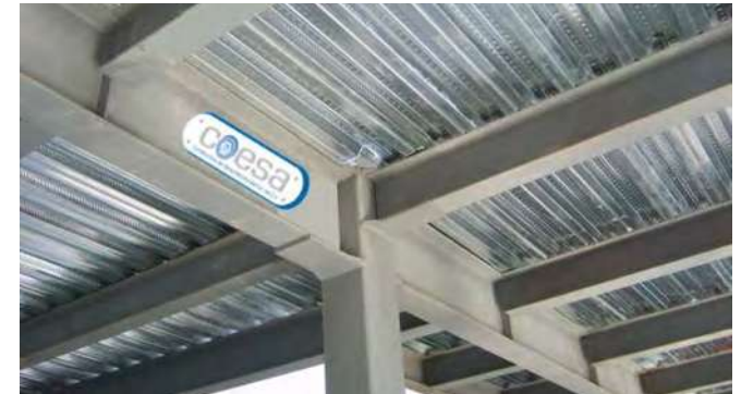
Fig 1.73 Losacero detalle de soportes, vigas primarias y secundarias donde se apoya la lámina, disponible en http://www.estructurascoesa.com.mx/proyectos.php?id=14 . Enero de 2016.
