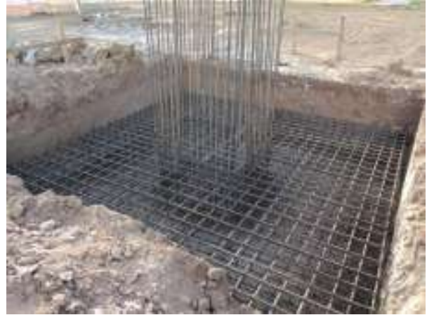
Ilustración 41 Zapata aislada de concreto armado http://2.bp.blogspot.com/-nzxwKRskREg/T4xD6e200TI/AAAAAAAAAT0/kse3E8cuuHc/s1600/zapataa.jpg
