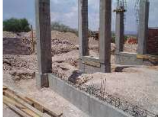
Ilustración 43 Columna de concreto http://www.aguascalientes.gob.mx/transparencia/calidad/sop/obras/ReportesVarios/imagen.asp?id=12867
