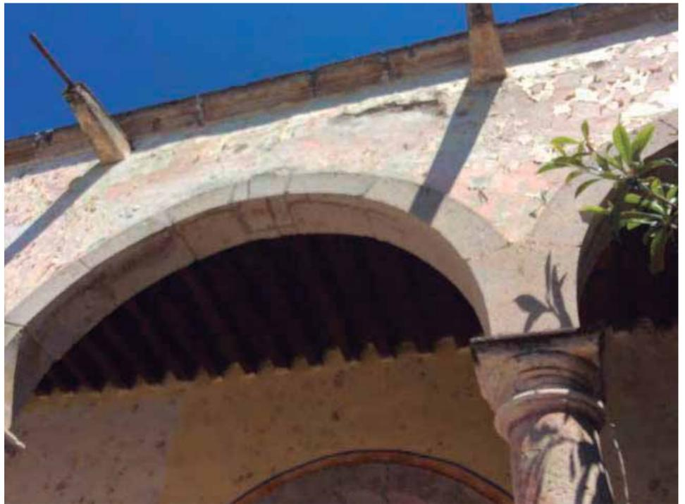
Se aprecian las vigas de madera, elemento estructural que sostienen la losa, que será analizada para ver su resistencia.
