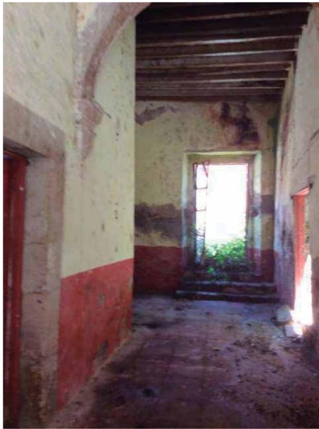
Pasillo que da al patio posterior, donde se observa el deterioro en muros techos y pisos.
