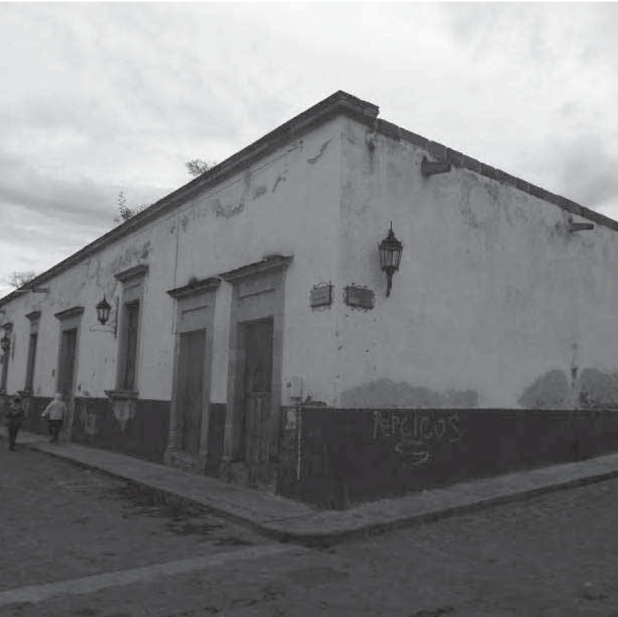
Esta es la fachada Sur, se aprecia la humedad que ha deteriorado los muros perimetrales.
