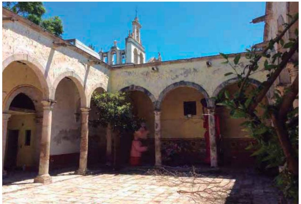
Se observa el deterioro de las columnas por elementos abióticos que requieren mantenimiento pero aún no se han dañado los elementos de manera estructural.
