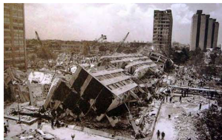
Imagen 1.5. Afectaciones de la Unidad Habitacional Nonalco Tlatelolco después del sismo de 1985.
