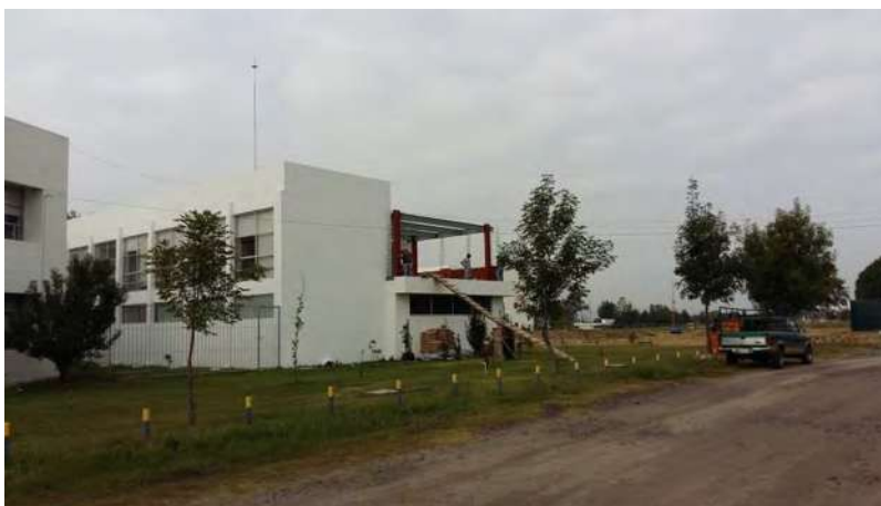
Ilustración #15: Trabajadores de la Construcción en Ciudad Universitaria. FOTOS: Autor.
