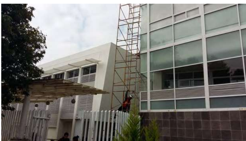
Ilustración #16: Trabajadores de la Construcción en Ciudad Universitaria. FOTOS: Autor.
