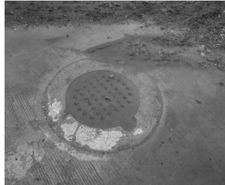
Poso de visita calle Francisco I. Madero Martínez: Fuente: fotografía Propia.
