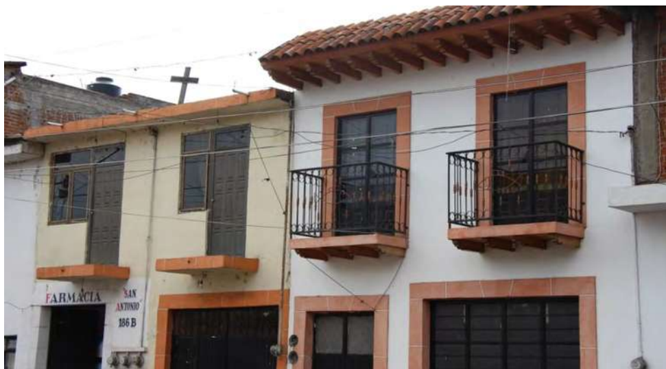
Imagen 011: Casas sobre la Av. Lázaro Cárdenas en Tzintzuntzan, Michoacán.
