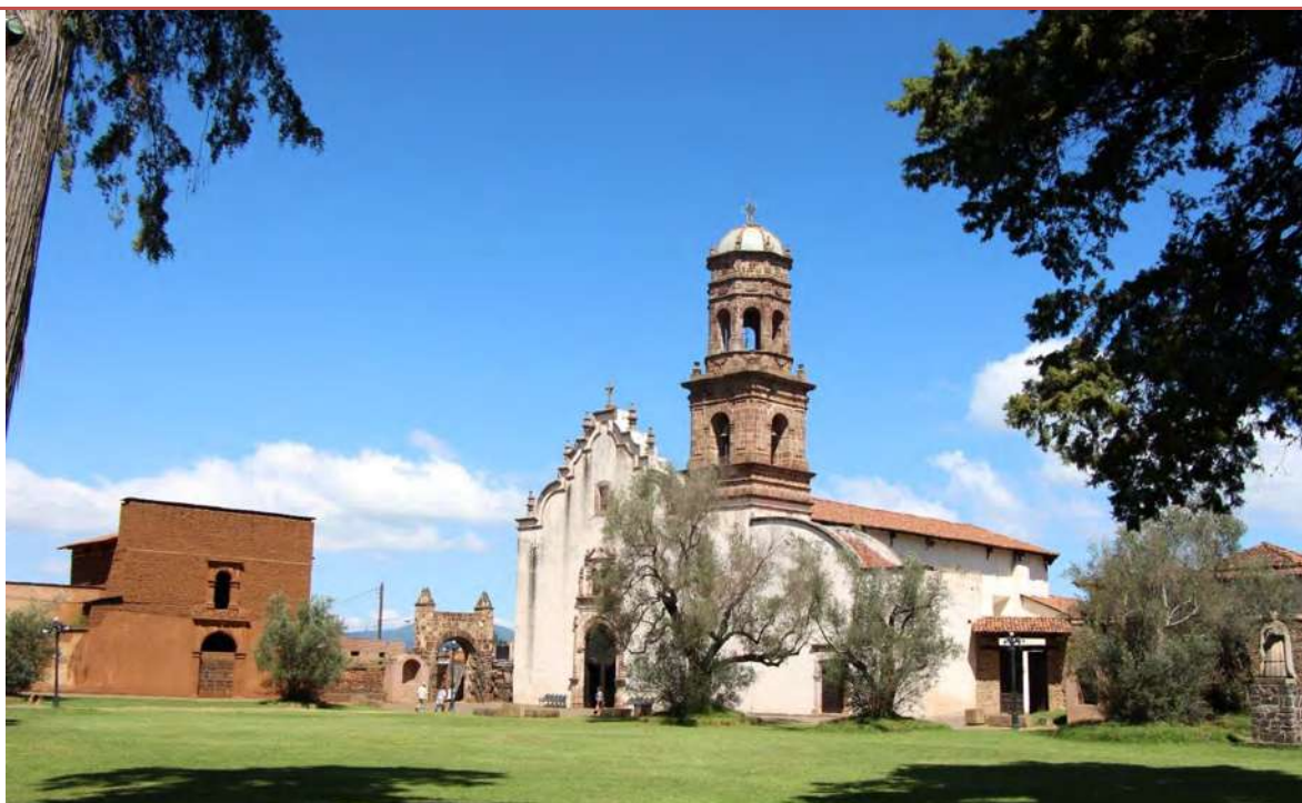
Imagen 045.- Templo de la soledad y el antiguo hospital de Indios, Tzintzuntzan, Michoacán.
