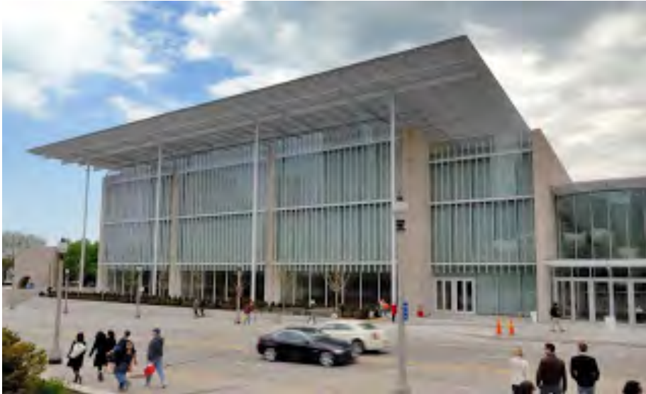
Imagen 9. Fachada de la Ampliación del Museo de Arte de Chicago.
