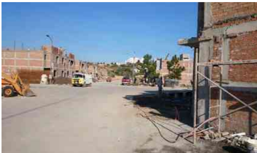
Img. 10. Albañilería casi terminada. Viviendas Aves III. Fotografía tomada por Jazmín Ávila.
