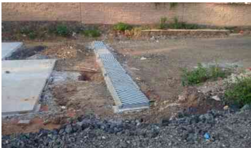
Img. 15. Rejilla de Colector Pluvial en Vialidad, Fracc. El Pinar. Fotografía tomada por Jazmín Ávila.
