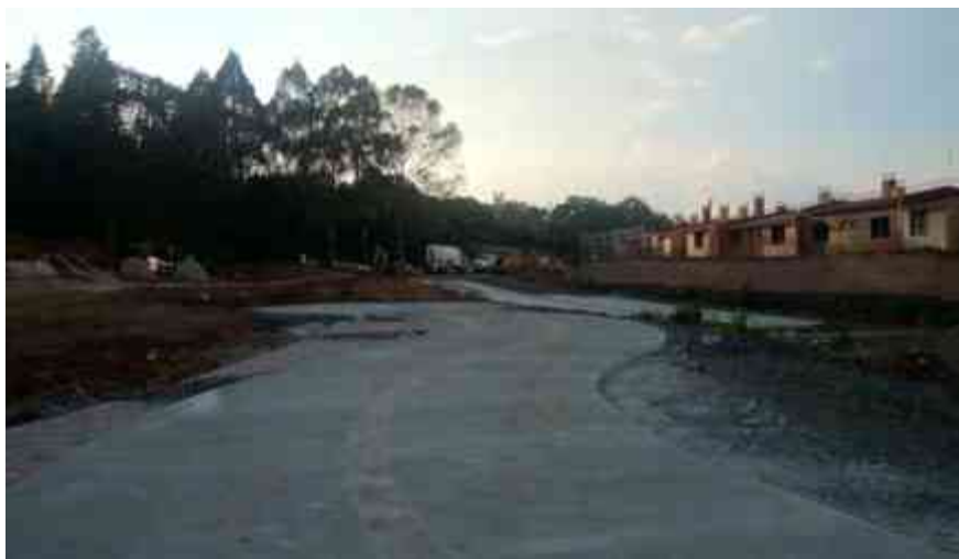
Img. 14. Pavimentación Vialidad con pórfido como división de la calle, Fracc. El Pinar. Fotografía tomada por Jazmín Ávila.
