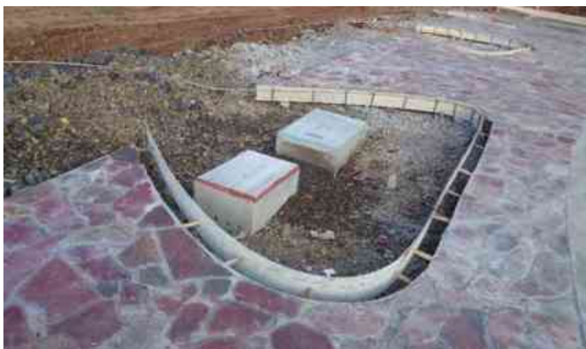
Img. 13. Cenefa de pórfido rojo y registros de de comunicación y electricidad. Fracc. El Pinar. Fotografía tomada por Jazmín Ávila.
