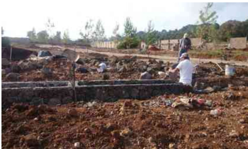
Img. 18. Construcción de Rodapié de Piedra para Barda Perimetral, Fracc. El Pinar. Fotografía tomada por Jazmín Ávila.
