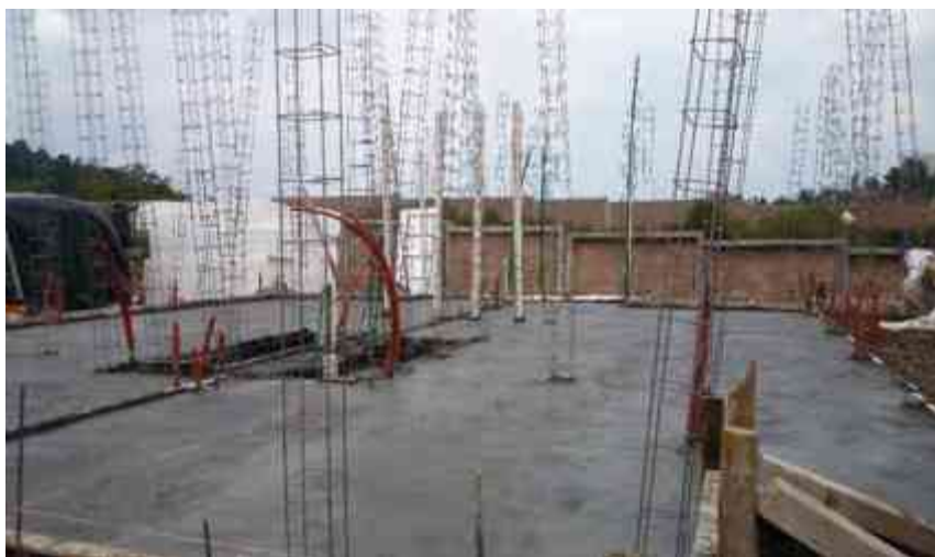
Img. 06. Colado de Losa Cimentación. Viviendas Aves III. Fotografía tomada por Jazmín Ávila.
