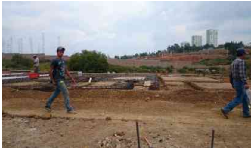
Img. 03. Armado de Losa de Cimentación. Viviendas Aves III. Fotografía tomada por Jazmín Ávila.
