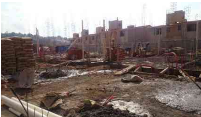
Img. 08. Inicio de levantamiento de Muros y colocación de Tubería de Drenaje. Viviendas Aves III. Fotografía tomada por Jazmín Ávila.
