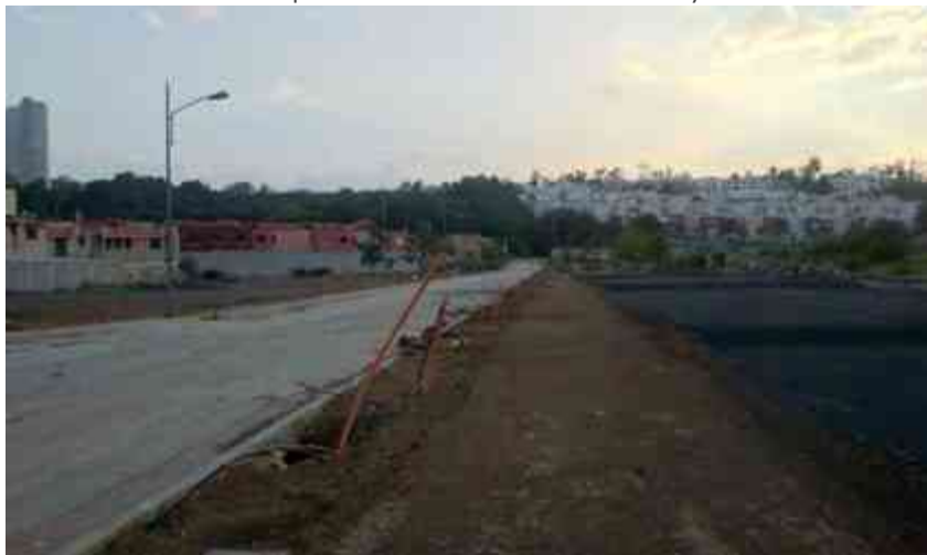
Img. 02. Vialidad y Plataformas de Viviendas Aves III. Fotografía tomada por Jazmín Ávila.
