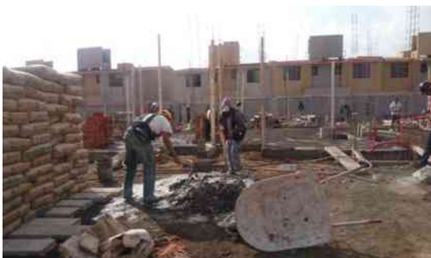
Img. 07. Colado de Losa Cimentación. Viviendas Aves III. Fotografía tomada por Jazmín Ávila.
