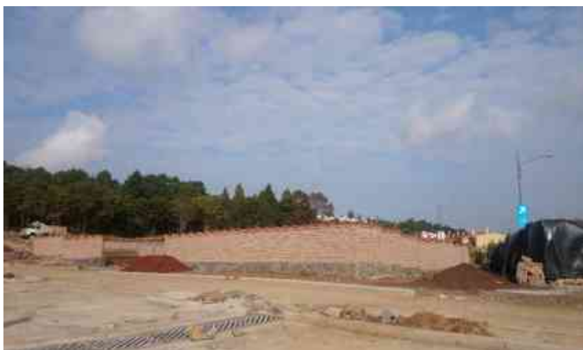
Img. 19. Bardas Perimetrales con block cara de piedra y rodapié de Piedra, Fracc. El Pinar. Fotografía tomada por Jazmín Ávila.
