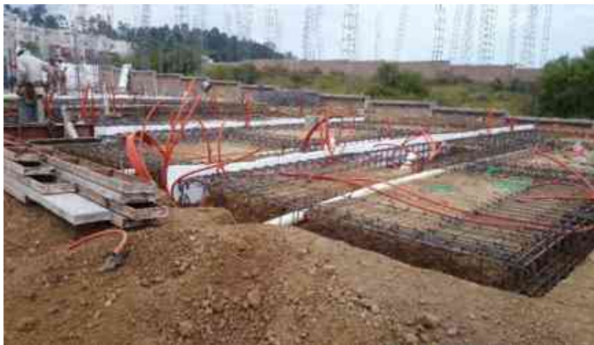
Img. 04. Armado de Losa de Cimentación con tubería de Electricidad y Drenaje. Viviendas Aves III. Fotografía tomada por Jazmín Ávila.
