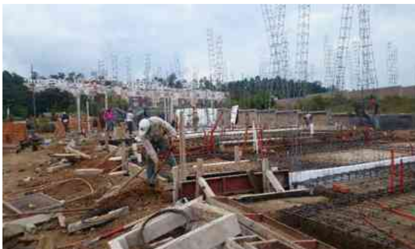
Img. 05 Cimbrado de Losa de Cimentación, castillos y tuberías de Instalaciones. Viviendas Aves III. Fotografía tomada por Jazmín Ávila.
