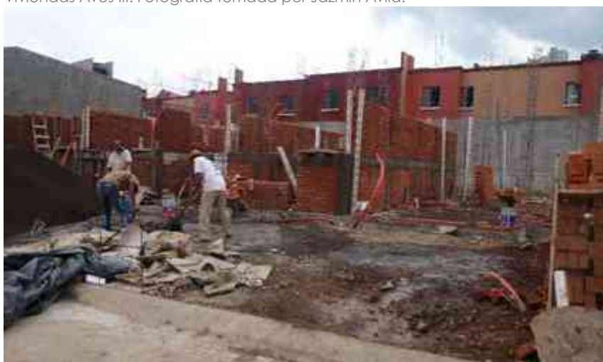
Img. 09. Avance de Muros y trabajando a la par plomeros, maestros y electricistas. Viviendas Aves III. Fotografía tomada por Jazmín Ávila.
