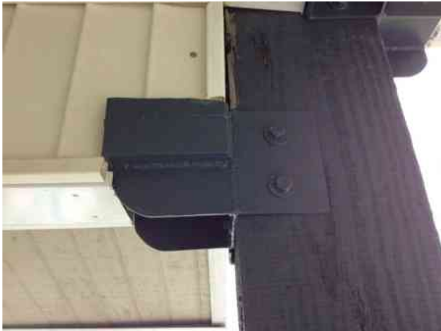
Fig. 72. Herrajes a reemplazar 1. Autor: JAPG.
