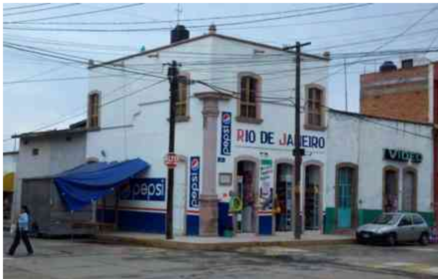
Fig. 18. Remodelación/Ampliación de la tienda “Rio de Janeiro”. Autor: JAPG.
