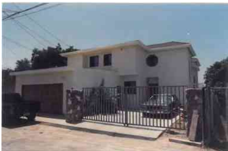
Fig. 6. Fachada terminada de la remodelación de la vivienda. Autor: JAPG.
