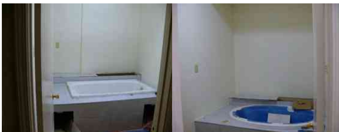
Fig. 26-27. Instalación de tinas. Autor: JAPG.
