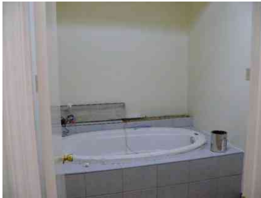
Fig. 28. Instalación de tinas y vitropiso. Autor: JAPG.
