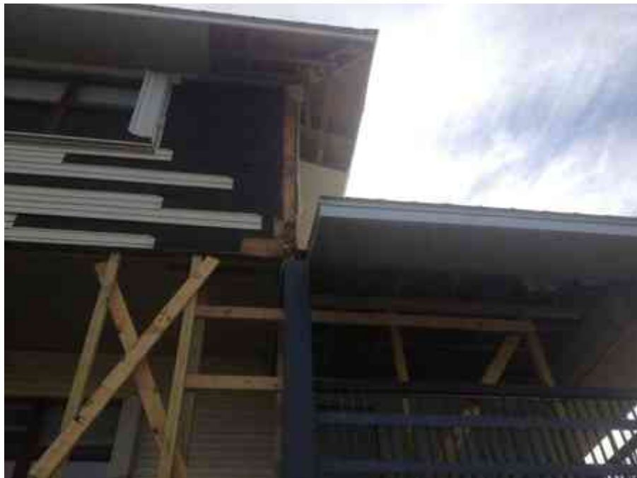
Fig. 74. Pilar cortado para facilitar reposición. Autor: JAPG.
