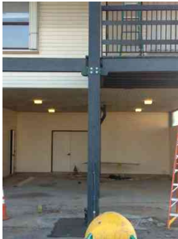
Fig. 77. Pilar de madera remplazado. Autor: JAPG.
