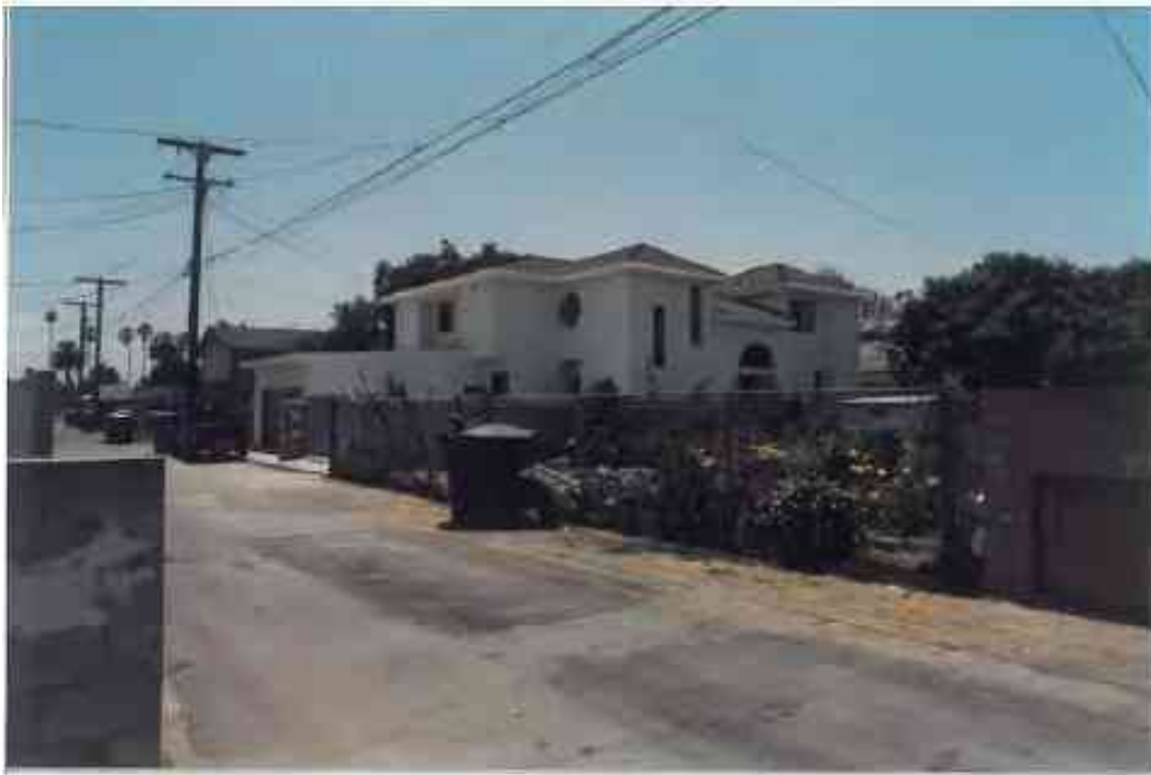
Fig. 7. Fachada terminada de la remodelación de la vivienda. Autor: JAPG.
