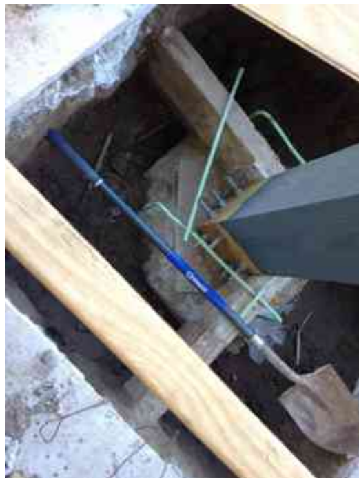
Fig.75. Anclaje de Pilar a cimentación existente. Autor: JAPG.
