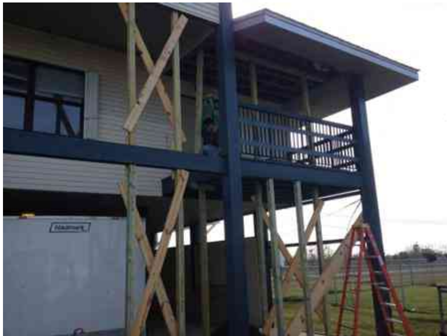
Fig. 68. Apuntalamiento para la remoción de pilar. Autor: JAPG.
