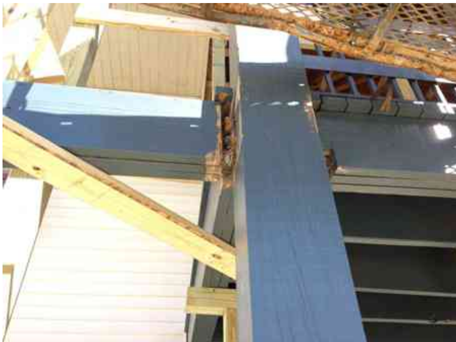
Fig. 67. Remoción de pilar. Autor: JAPG.
