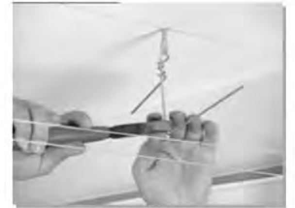
Doble los alambres del colgante a la altura de la cuerda guía
