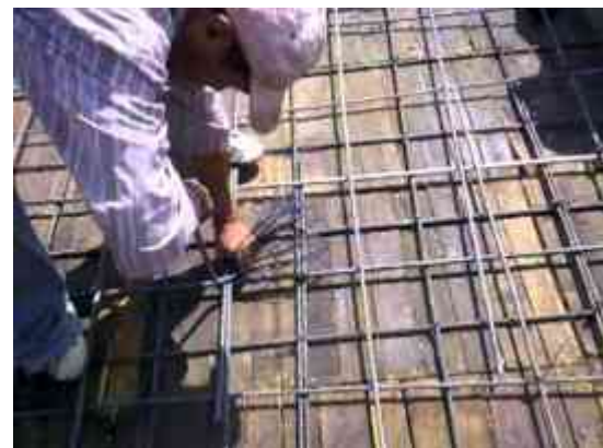
Fig.96 emparrillado de varillas de doble tendido https://i.ytimg.com/vi/IIA0ExiktCg/hqdefault.jpg
