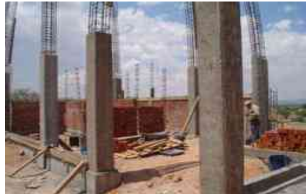
Fig. 89 columnas de concreto reforzado con un f'c 250kg/cm2. http://www.arqhys.com/construccion/fotos/construccion/Columnas-de-concreto.jpeg
