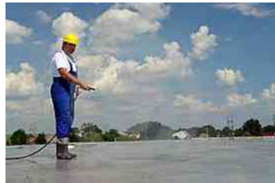
Fig. 95 Curado de concreto con agua para evitar grietas http://www.academica.mx/categorias/temas-inter%C3%A9s/educaci%C3%B3n-humanidades-y-artes/arquitectura
