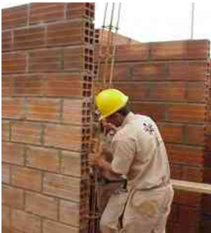
Fig. 93 trabajadores en colocación de materiales prefabricados http://4.bp.blogspot.com/_DXCFD184Lwo/SfhqpL1hjyI/AAAAAAAAAA/s/5mG9EMt6XXQ/s320/construccion.jpeg
