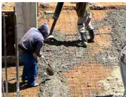
Fig.92 Colocacion de firme de concreto https://i.ytimg.com/vi/4sNHlUmlUUU/hqdefault.jpg
