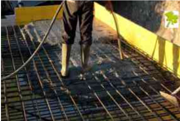
Fig. 88 colocacion de concreto de 250kg/cm2 para losa maciza https://i.ytimg.com/vi/9TOFopHMDY/maxresdefault.jpg
