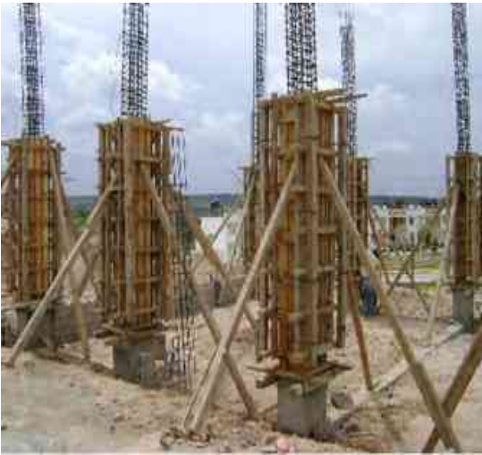
fig.94 cimbrado de columnas de concreto http://www.aguascalientes.gob.mx/transparencia/calidad/sop/obras/ReportesVarios/imagen.asp?id=47501
