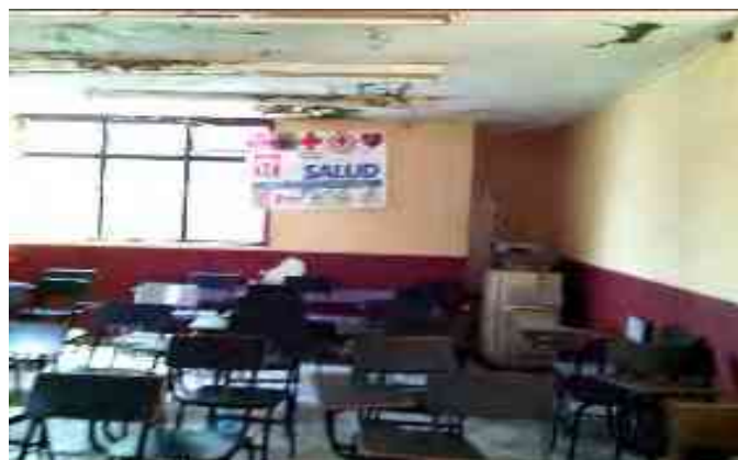
Foto 002. Estado actual del Aula de Voluntariado. Fuente: Gonzalo Serafín Estrada.
