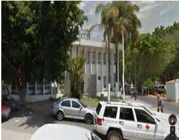
Foto 065. Fachada Lateral. Fuente: Google Earth.
