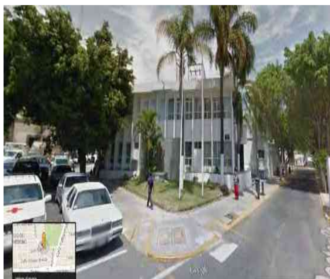
Foto 070. Fachada lateral. Fuente: Google Earth.
