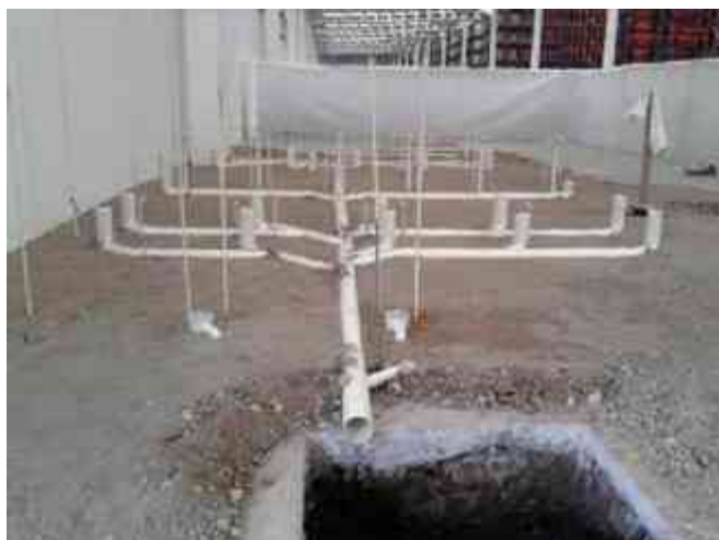
Fig. 37- Sistemas hidrosanitarios deben ser hechos mientras las superficies están todavía mojadas o húmedas y el pegamento esté todavía líquido.
