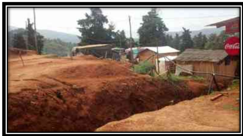
Figura 19. Apertura de tierra por escurrimientos.
