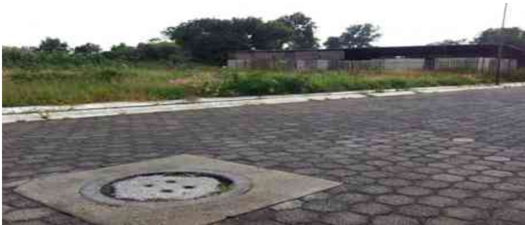
Imagen 20 – Red de alcantarillado y pavimentación.
