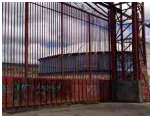
Fig. 30 El Relicario ubicado hacia el este del terreno.
