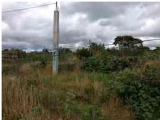
Fig. 27. Foto 7 Vista de uno de los postes de luz del predio
