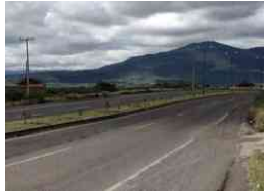
Fig. 37 Vialidad principal vista hacia suroeste. Fuente: autor
