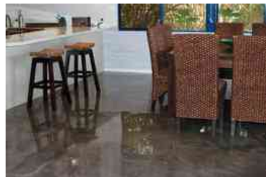
Fig. 97. Interior piso interior de concreto oxidado color gris Oxford Fuente: datos obtenidos en google. 11/12/2014
