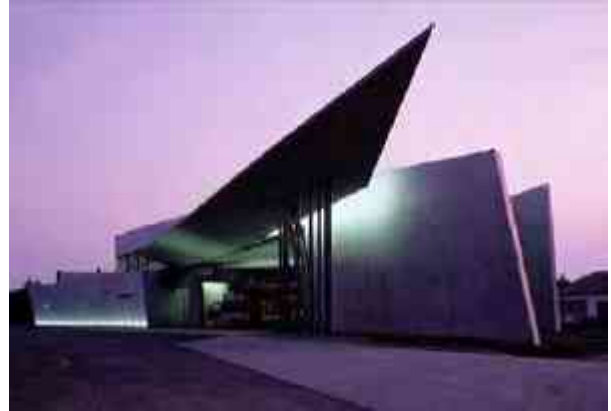
Fig. 61. Fachada principal de la estación Vitra
