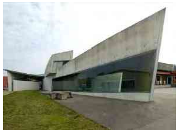
Fig. 62. Fachada posterior de la estación Vitra
