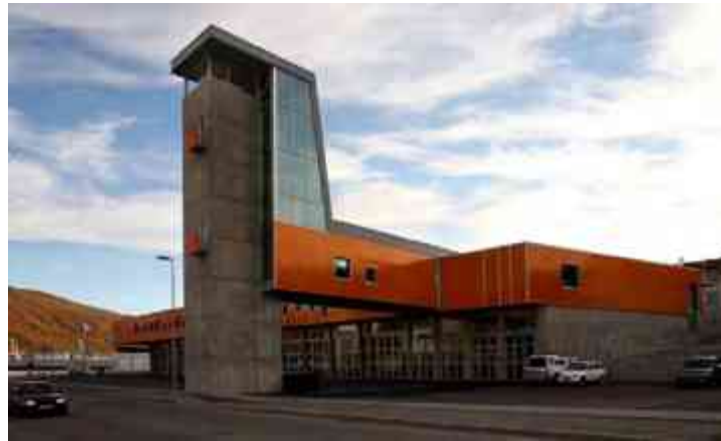
Fig. 53. Torre de control estación de bomberos Stein Halvorsen Fuente: datos obtenidos en google. 08/01/2017
