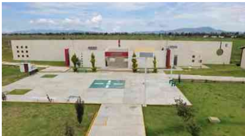
Figura 20: Patio principal en las instalaciones de Universidad Politécnica de Tulancingo. Url: http://cgut.sep.gob.mx/UUPP/UPTulancingo/220216/bt_uptulancingo220215.php , 2017.
