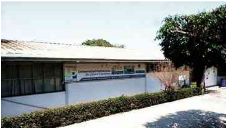
Figura 06: Área Administrativa. Edificio prestado por parte del Conalep 035 a Universidad Politécnica de Lázaro Cárdenas, acondicionado para su uso académico. Fuente: JVBA, Marzo, 2017.
