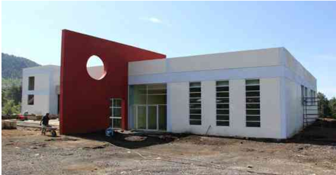
Figura 22: Vista departamento administrativo en momento de construcción, en instalaciones de Universidad Politécnica de Uruapan.
