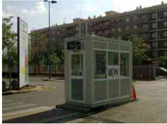
Fig. 67. Caseta de vigilancia y control de acceso. Fuente: Google imagen. Fecha de consulta: Mayo 2017.
