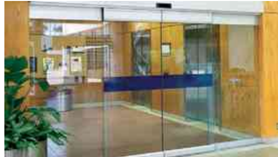
Fig. 75. Puertas automáticas con sensores de movimiento para clínicas y hospitales. Fuente: Google imagen. Fecha de consulta: Mayo 2017.
