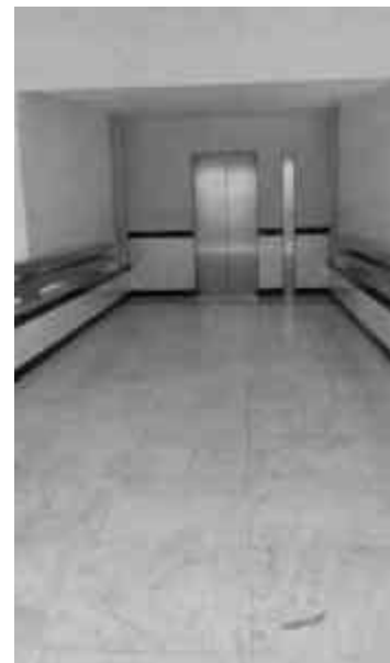
Fig. 52. Elevador. Vista en la planta alta. Fuente: MISV Fecha: enero 2017.
