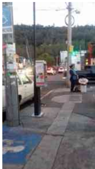
Fig. 37. Postes, automoviles, casetas telefonicas, vendedores ambulantes que invaden banquetas y rampas para los pacientes. Fuente: MISV Fecha: enero 2017.
