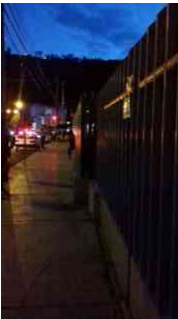
Fig. 56. Falta de alumbrado público en la banqueta de la UMF No. 75 IMSS. Fuente: MISV Fecha: enero 2017.
