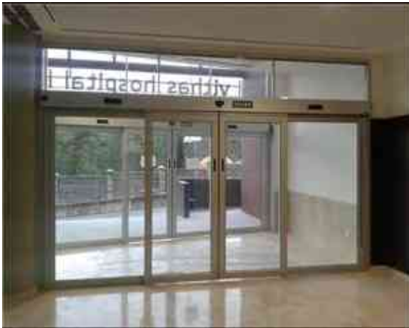
Fig. 74. Puertas automáticas con sensores de movimiento para clínicas y hospitales. Fuente: Google imagen. Fecha de consulta: Mayo 2017.
