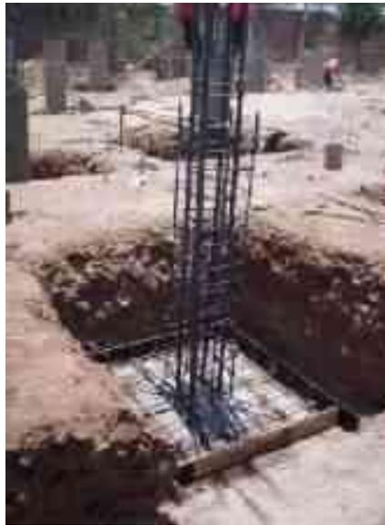
ILUSTRACIÓN 78 ZAPATA AISLADA, FOTOGRAFÍA,
