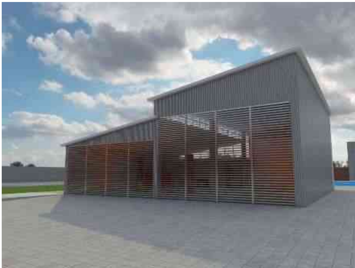
IMAGEN. 23 Fachada Frontal, Taller de Mantenimiento y Descontaminación”.
