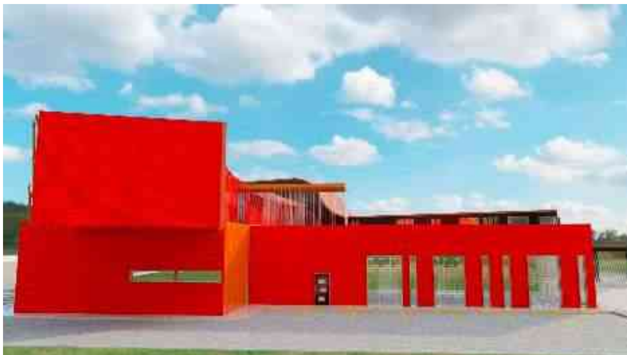
IMAGEN. 19 Fachada Lateral Vista sur, Administración "Protección Civil".
