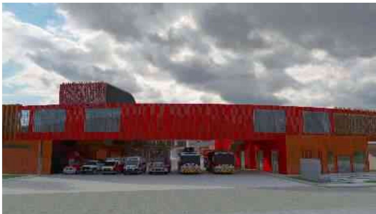
IMAGEN. 15 Fachada Principal, Unidad de Protección Civil y Bomberos, vista este.
