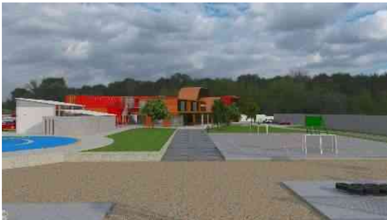
IMAGEN. 27 Vista posterior, conjunto Unida de Protección Civil y Bomberos.
