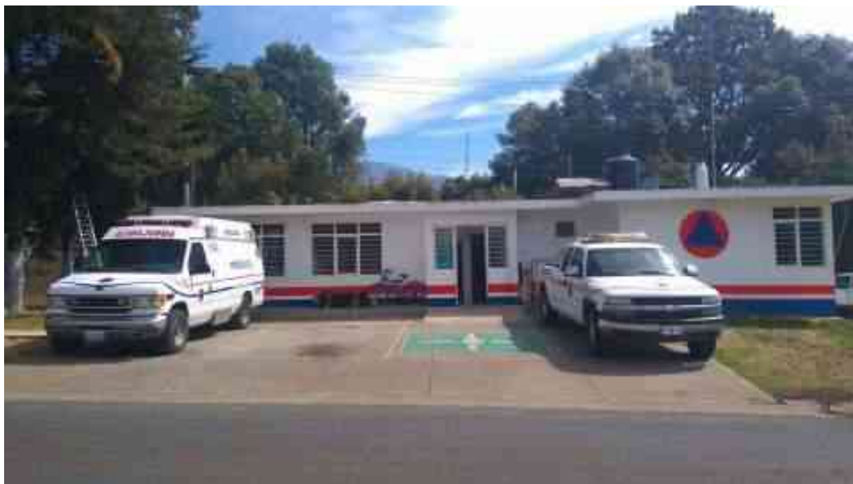
IMAGEN 2. Instalaciones de Protección Civil, Tancítaro Michoacán, Fuente: Fotografía tomada en sitio.
