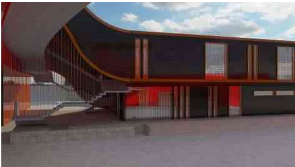
IMAGEN. 22 Vista lateral sur, área operativa de Protección Civil y Bomberos.
