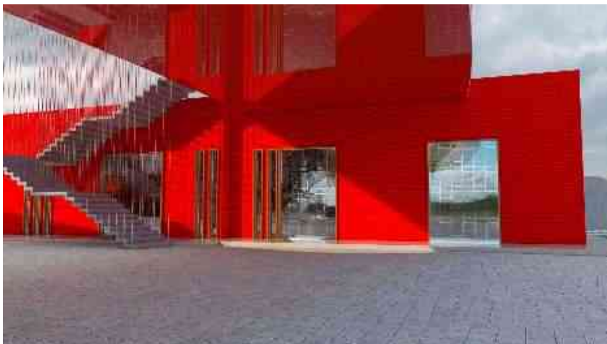
IMAGEN. 20 Fachada Lateral Vista Norte, Administración "Protección Civil".
