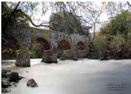
Fig.31 Puente de Batanes en Salvatierra Gto. Foto: Miguel Zarate
