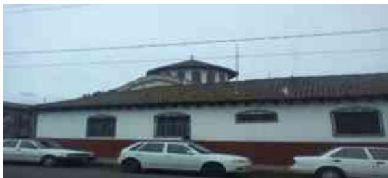
Figura: 5: Muestra los materiales de construcción que se utilizaban, tomada en 15 de febrero de 2012 a las 15:00 hrs.
