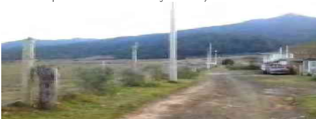
Figura29. Imagen tomada propiamente el día 27 de enero de 2017, muestra la red de energía eléctrica media tensión que pasa por el terreno.
