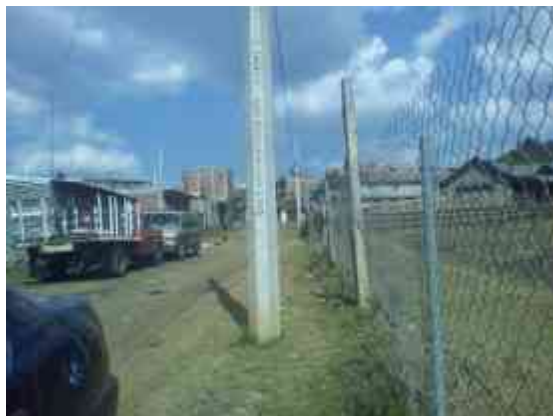
Figura 38: Muestra ubicación de la red eléctrica en el terreno sobre la calle Nicolás Romero, tomada personalmente el día 8 de Febrero de 2012 a las 16 hrs.
