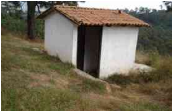
Imagen 87 de los baños existentes en el cerro hueco /JAHR
