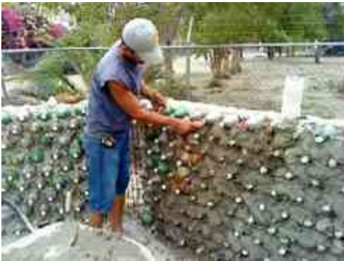
Imagen Se muestra un trabajador de la construcción durante la Colocación de botellas de pet para la creación de muros. Fuente: https://i.ytimg.com/vi/kjGGqTx65S8/hqdefault.jpg
