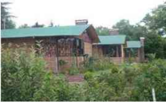
Imagen 66 Se muestra la Vista exterior del Restaurante. Fuente: http://tuespacio.com/wp-content/uploads/2011/11/Centro-Ecotur%C3%ADstico-del-Lago-Huasca-de-Ocampo.jpg 12/11/15
