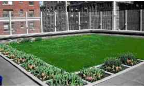
Imagen 139, azotea verde de un edificio/ https://ecotecnologiasparaelbienestar.files.wordpress.com
