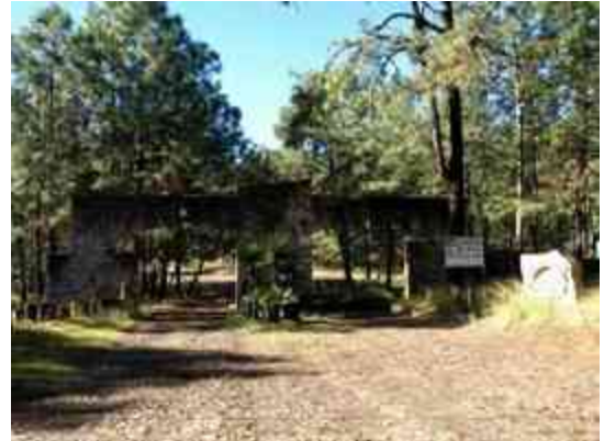
Imagen 37, Acceso principal al parque ecológico cerro hueco, JAHR
