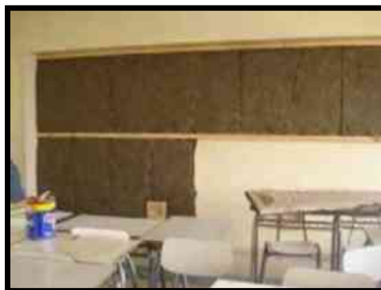
2. Paneles de lana mineral, pegados sobre muro.
