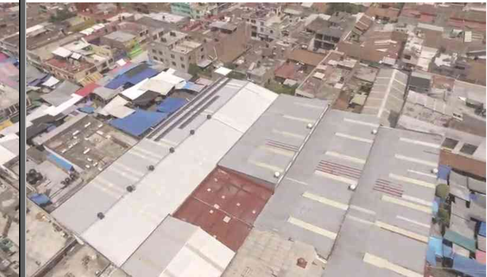
70. Cubierta del mercado Morelos, sus estacionamientos utilizados por el tianguis, la calle Juárez y privada de Juárez. Fotografía propia.
