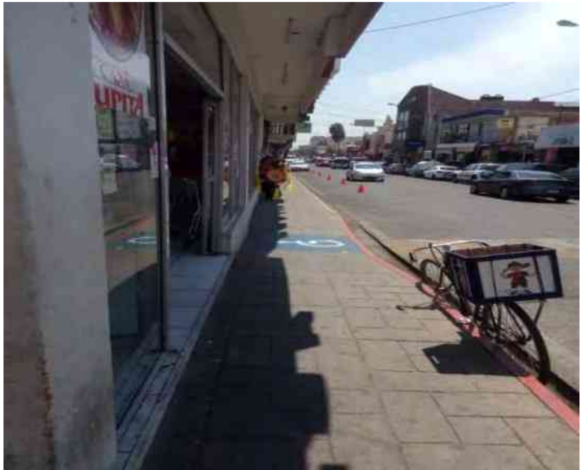
57. Avenida Morelos. Fotografía propia
