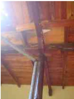
Elementos agregados al original y pudrición de piezas de madera.
