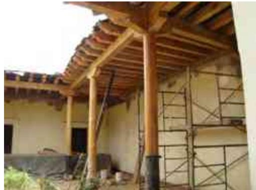
Colocación de vigas de plafón y columnas en pasillos de patio.
