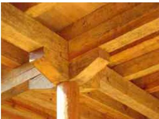
Detalle de ensamble en zapatas, vigería, columna y tapa de tabla en plafón de madera.
