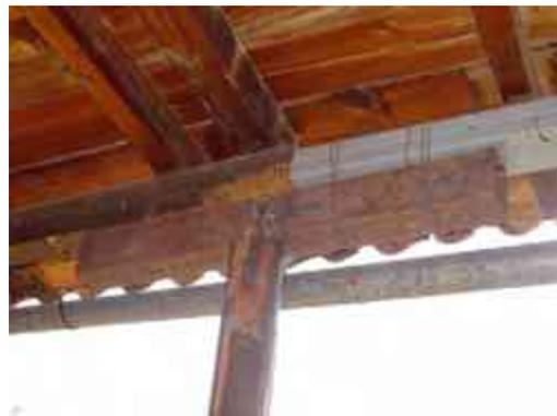
Vigas de madera con deterioros y faltantes.
