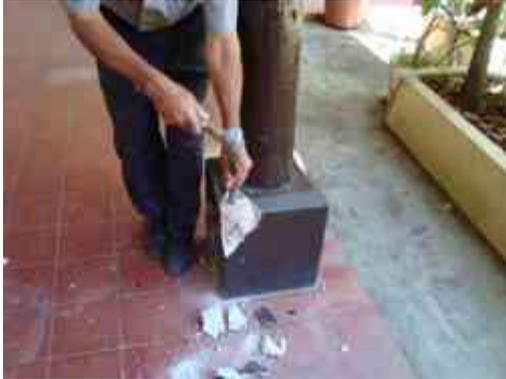
Demolición de recubrimiento en base de cantera.
