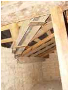
Canales de bajadas de agua pluviales en mal estado.
