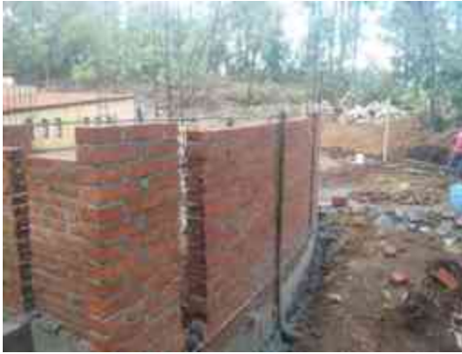
Imagen 75. Colocación de tabique
