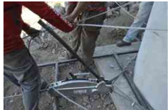
Imagen 52. Colocación de tiford para tensar cable de acero de la tirolesa en Tecuena.
