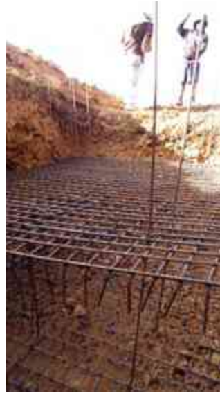
Imagen 42. Armado de zapata Fuente: Manuel Ávila Serrano.
