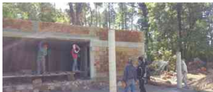
Imagen 90. Aplanado de plafón y muros
