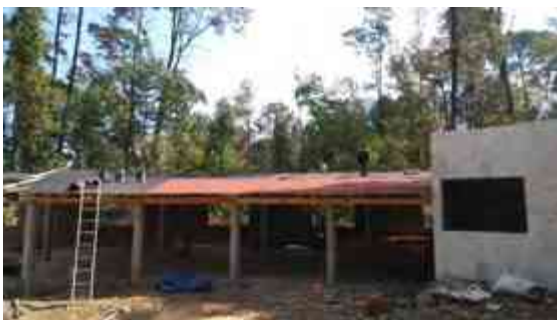
Imagen 100. Colocación de impermeabilizante asfáltico.
