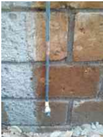
Imagen 87. Alimentación de agua potable
