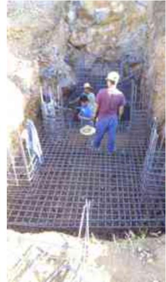
Imagen 43. Armado de columnas Fuente: Manuel Ávila Serrano.
