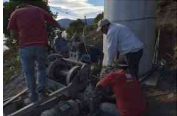
Imagen 51. Colocación de máquina para tensar cable de acero de la tirolesa en Tecuena.
