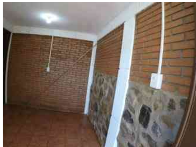
Imagen 62. Terminado interior de muro de piedra laja en la tienda bodega.
