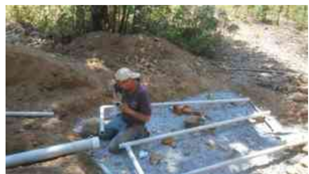
Imagen 97. Salida de agua del Biodigestor de la fuente de sodas.
