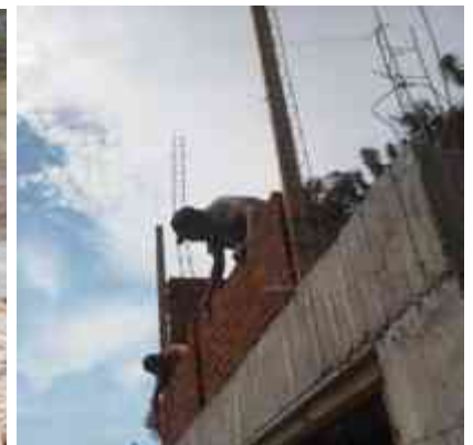
Imagen 56. Colocación de tabique en tienda bodega en isla Tecuena.
