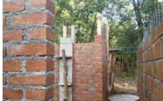
Imagen 80. Colocación de trabe de cerramiento
