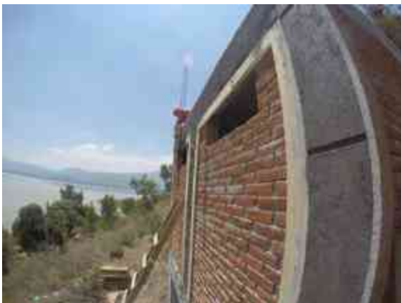
Imagen 59. Emboquillado de castillos y trabes.
