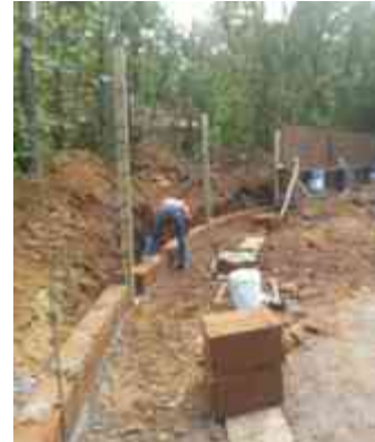
Imagen 76. Colocación de sillar
