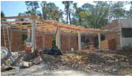
Imagen 98. Colocación de vigas de madera de 4 x 6 pulgadas.
