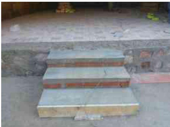
Imagen 93. Construcción de escalera.
