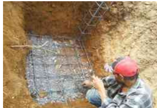
Imagen 72. Zapatas aisladas en área de comensales.
