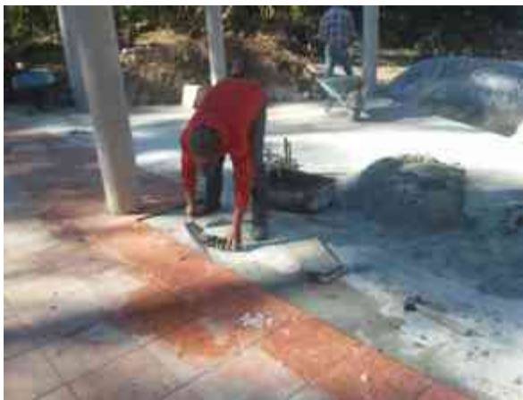
Imagen 91. Colocación de piso cerámico.
