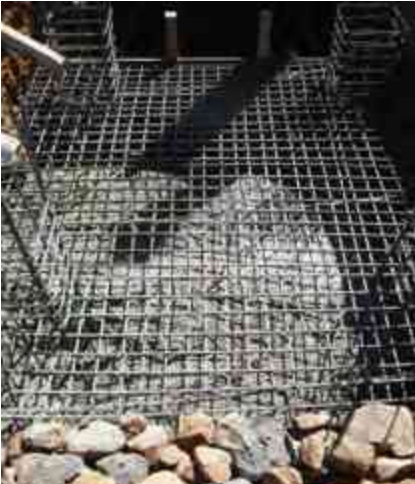
Imagen 47. Cimbrado y colado de zapata en isla de Janitzio.
