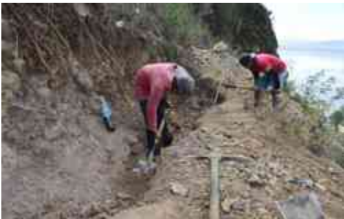
Imagen 54. Excavación de cimentación y losa de tienda bodega isla Tecuena
