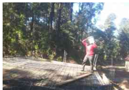
Imagen 82. Colado de losa maciza.
