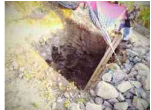
Imagen 39. Excavación de la zapata
