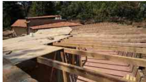
Imagen 99. Colocación de duela de madera en tejado.
