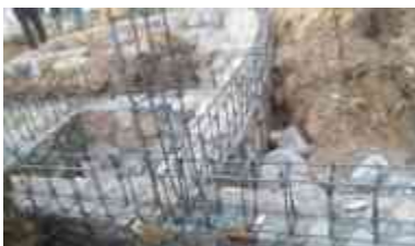
Imagen 73. Trabe de despalme para muro de tabique y sillar.
