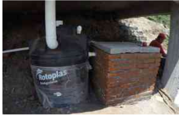
Imagen 58. Instalación de biodigestor rotoplas y registro.
