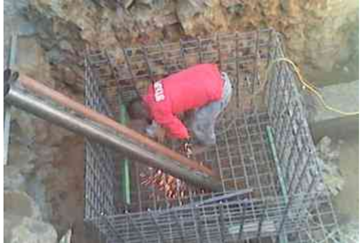
Imagen 48. Colocación de tubos de acero para anclaje de cable de acero en isla de Janitzio.
