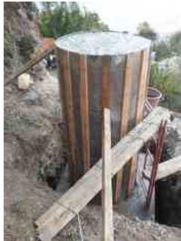
Imagen 45. Cimbrado y colado de columna.
