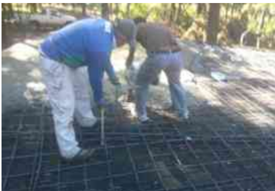
Imagen 81. Armado de losa maciza.
