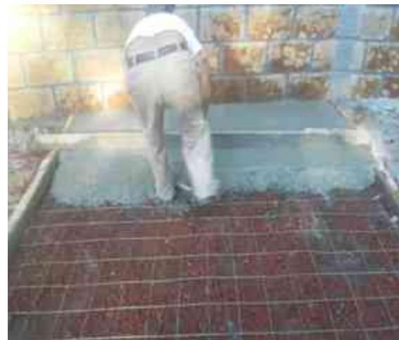
Imagen 86. Colado de firme con malla electrosoldada.
