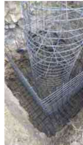
Imagen 46. Armado de dado columna y zapata.
