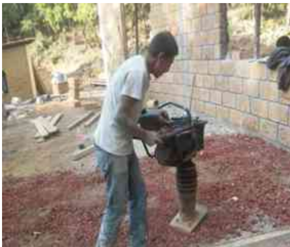
Imagen 85. Compactando piso para colocación de firme
