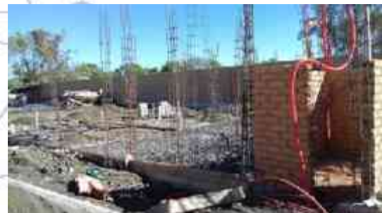
Ilustraciones 62/63/64/65: Fotografías de colocación de cimbra y excavación en la Obra Residencial Castellón, Hacienda Peñasco | Tomada por Luis Enrique Zetina C.
