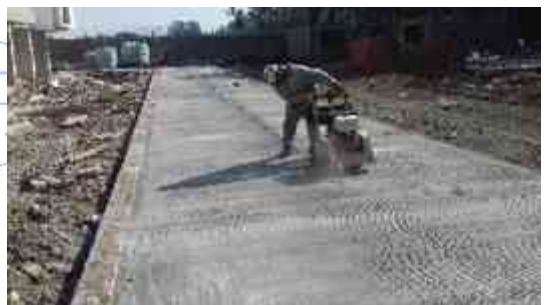
Ilustraciones 27/28/29/30: Fotografías de colado y corte en calle de la Obra Residencial Castellón, Hacienda Peñasco | Tomada por Luis Enrique Zetina C.
