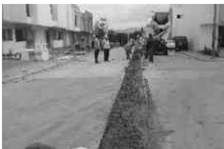
Ilustraciones 24/25/26: Fotografías de colocación de molde para el acabado en la línea central de la calle en la Obra Residencial Castellón, Hacienda Peñasco | Tomada por Luis Enrique Zetina C.
