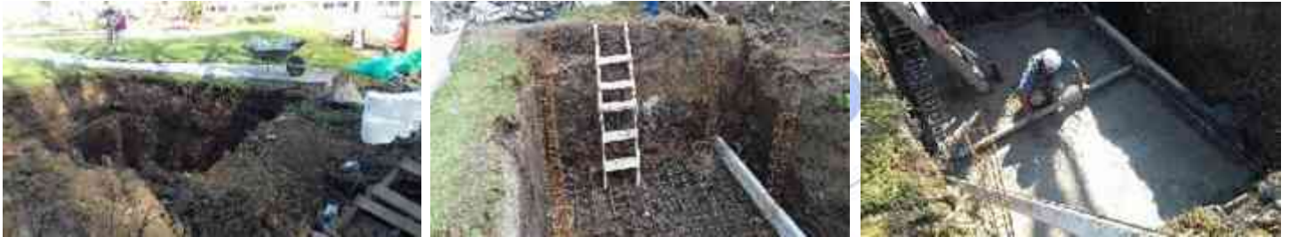
Ilustraciones 31/32/33: Fotografías de construcción de la cisterna para el área verde de la Obra Residencial Castellón, Hacienda Peñasco | Tomada por Luis Enrique Zetina C.
