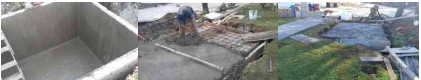
Ilustraciones 37/38/39: Fotografías de construcción de la cisterna para el área verde de la Obra Residencial Castellón, Hacienda Peñasco | Tomada por Luis Enrique Zetina C.
