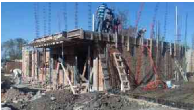
Ilustraciones 70/71: Fotografías de armado de losa de entrepiso y cimentación en la Obra Residencial Castellón, Hacienda Peñasco | Tomada por Luis Enrique Zetina C.
