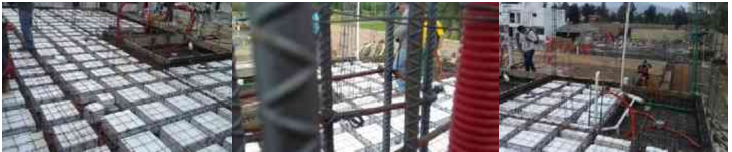
Ilustraciones 79/80/81: Fotografías de colocación de casetones en la Obra Residencial Castellón, Hacienda Peñasco | Tomada por Luis Enrique Zetina C.
