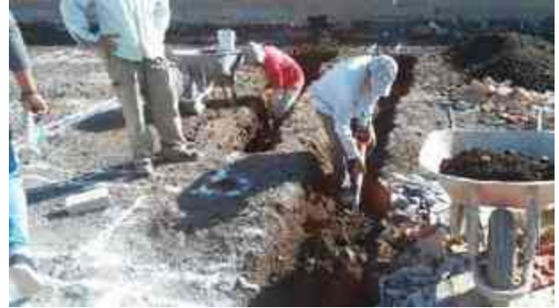
Ilustraciones 22/23: Fotografías de trazo y excavación en la Obra Residencial Castellón, Hacienda Peñasco | Tomada por Luis Enrique Zetina C.
