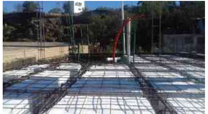
Ilustraciones 68/69: Fotografías de armado de losa de entrepiso en la Obra Residencial Castellón, Hacienda Peñasco | Tomada por Luis Enrique Zetina C.
