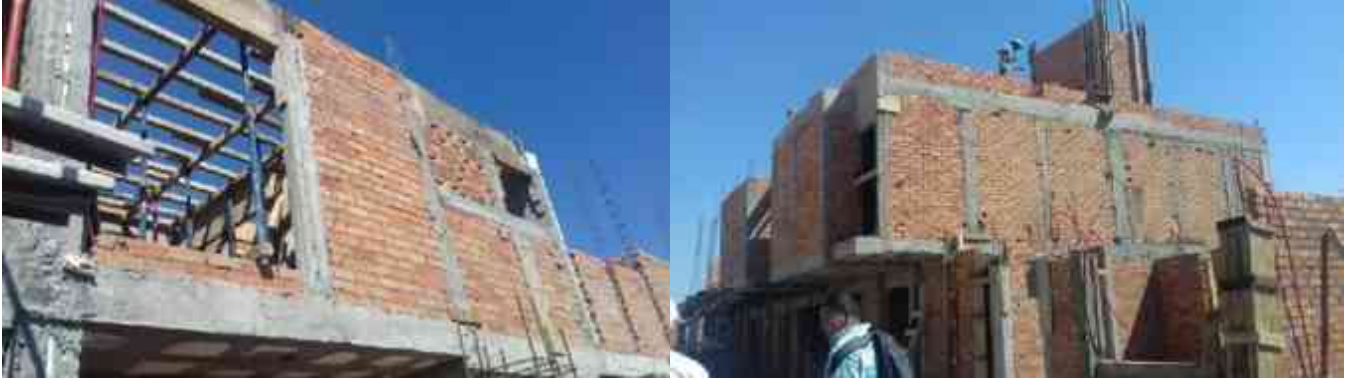
Ilustraciones 86/87: Fotografías de cimbrado en planta alta en la Obra Residencial Castellón, Hacienda Peñasco | Tomada por Luis Enrique Zetina C.
