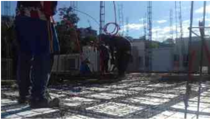
Ilustraciones 68/69: Fotografías de armado de losa de entrepiso en la Obra Residencial Castellón, Hacienda Peñasco | Tomada por Luis Enrique Zetina C.
