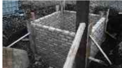
Ilustraciones 10|11|12: Fotografías de construcción de cisterna de la Obra Residencial Castellón, Hacienda Peñasco | Tomada por Luis Enrique Zetina C.
