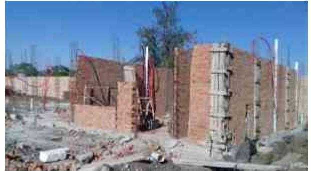
Ilustraciones 55/56/57/58: Fotografías del levantamiento de muros de tabique en la Obra Residencial Castellón, Hacienda Peñasco | Tomada por Luis Enrique Zetina C.
