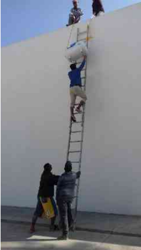
Ilustración 17: Fotografía de traslado de tanques estacionarios en la Obra Residencial Castellón, Hacienda Peñasco | Tomada por Luis Enrique Zetina C.
