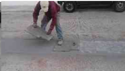
Ilustraciones 24/25/26: Fotografías de colocación de molde para el acabado en la línea central de la calle en la Obra Residencial Castellón, Hacienda Peñasco | Tomada por Luis Enrique Zetina C.
