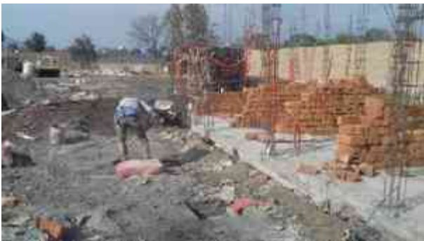
Ilustraciones 52/53/54: Fotografías del levantamiento de muros de tabique en la Obra Residencial Castellón, Hacienda Peñasco | Tomada por Luis Enrique Zetina C.
