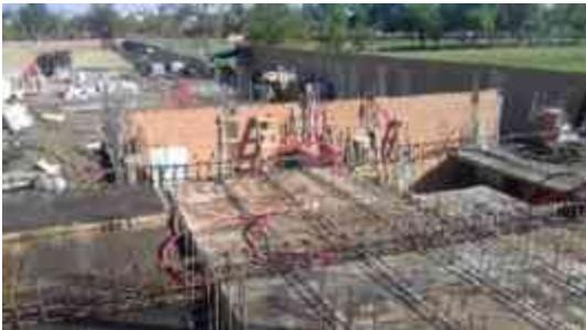
Ilustraciones 72/73/74: Fotografías de armado de losa de entre piso y tabique para planta alta en la Obra Residencial Castellón, Hacienda Peñasco | Tomada por Luis Enrique Zetina C.
