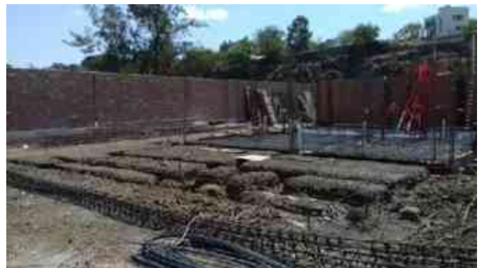
Ilustraciones 70/71: Fotografías de armado de losa de entrepiso y cimentación en la Obra Residencial Castellón, Hacienda Peñasco | Tomada por Luis Enrique Zetina C.
