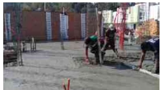
Ilustraciones 75/76/77/78: Fotografías de colado en cimentación en la Obra Residencial Castellón, Hacienda Peñasco | Tomada por Luis Enrique Zetina C.
