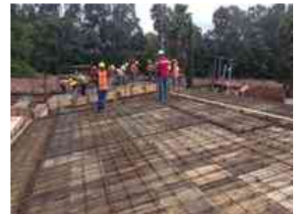
ARMADO DE LOSA INCLINADA
