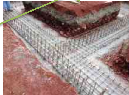
ARMADO DE ZAPATA CORRIDA
