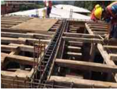
ARMADO TRABE DE CARGA
