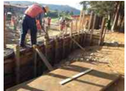
COLADO DE ZAPATA PARA BARDA PERIMETRAL
