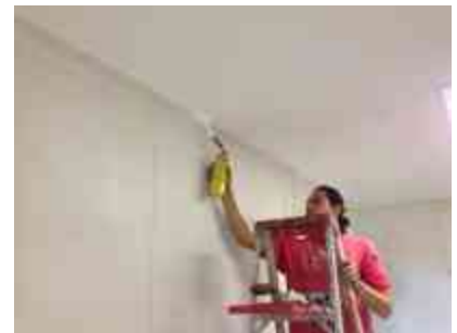
RECUBRIMIENTO DE PVC PARA MURO
