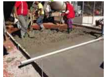
VACIADO DE CONCRETO EN ACCESO DE ESTACIONAMIENTO
