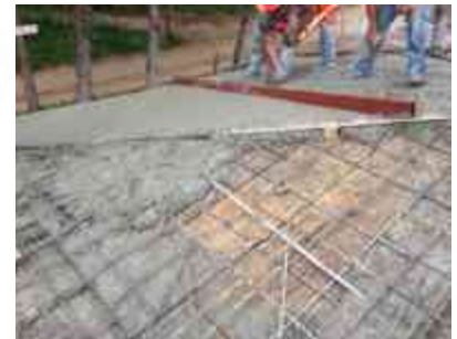
VACIADO DE CONCRETO
