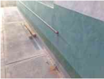
TUBERIA DE COBRE TIPO "L"
