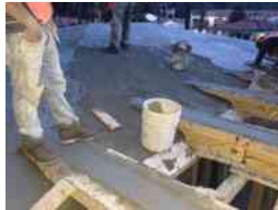
TERMINADO DEL CONCRETO FRESCO
