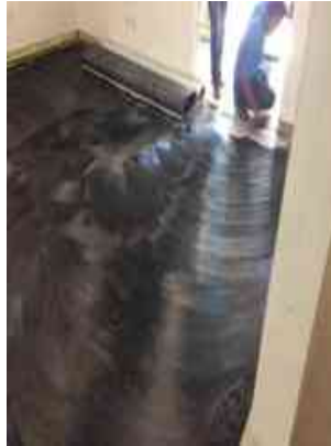
APLICACION DE ADHESIVO CONDUCTOR
