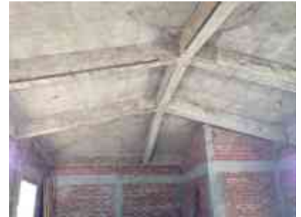
LOSA CON TERMINADO APARENTE
