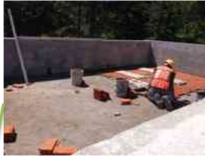
ENLADRILLADO PARA DAR PENDIENTE
