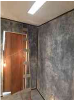
MURO PULIDO CON CURVA SANITARIA
