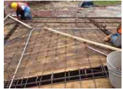
ARMADO DE TRABES Y LOSA
