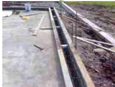
GUARNICION EN ESTACIONAMIENTO
