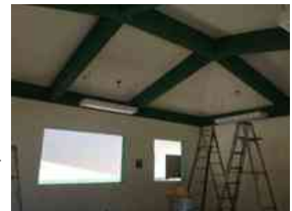
TERMINADO INTERIOR DE LA LOSA DEL CARA
