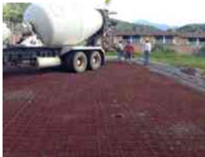
VACIADO DE CONCRETO EN ESTACIONAMIENTO
