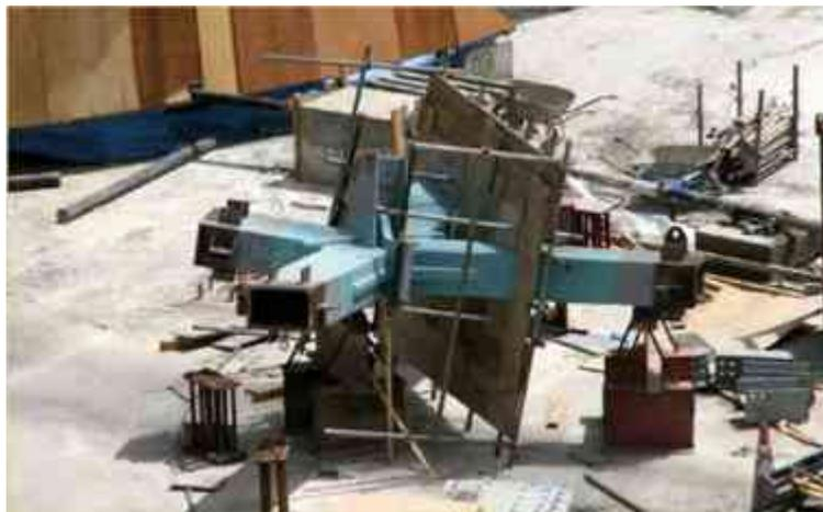
**Imagen 81: Nodo del sistema Diagrid. Fuente: <http://documents.mx/documents/diagridestructuras3-2010.html#>**
