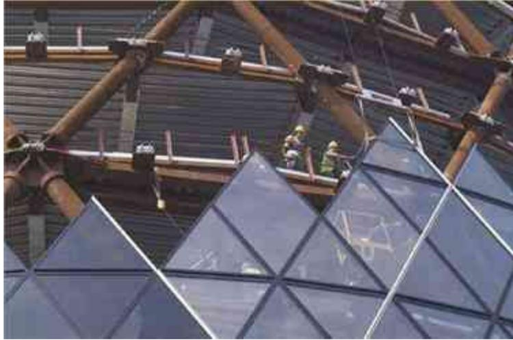
**Imagen 80: Exoesqueleto complementado por una envolvente de cristal. Fuente: <http://documents.mx/documents/diagridestructuras3-2010.html#>**
