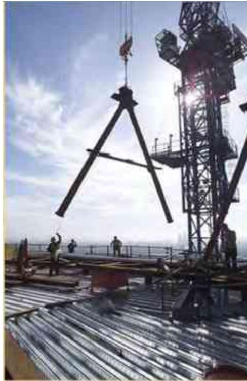
**Imagen 83: Sistema de entrepiso compatible con el Diagrid. Fuente: <http://documents.mx/documents/diagridestructuras3-2010.html#>**
