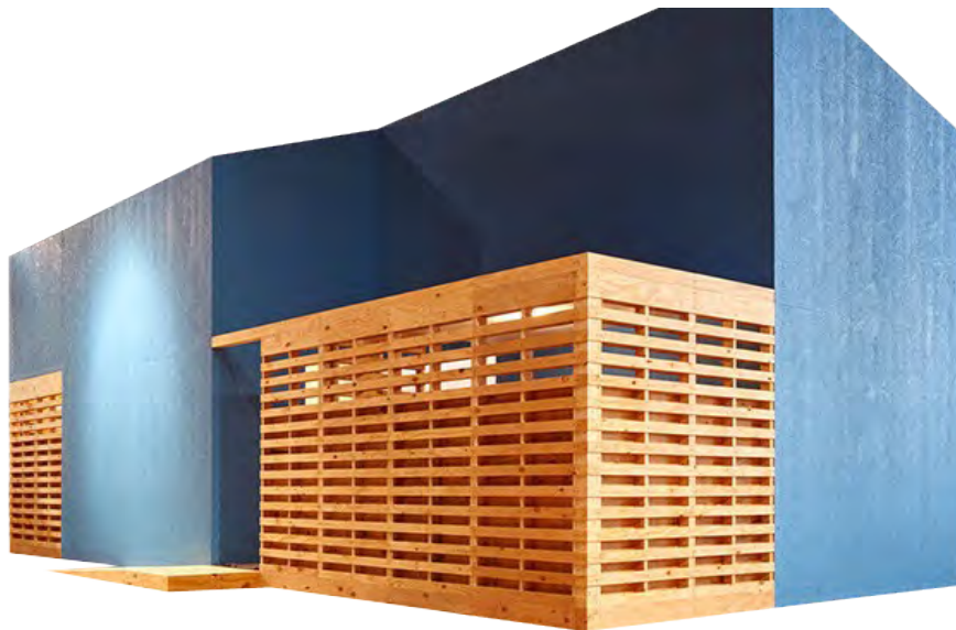
Ilustración 58. Prototipo Vivienda Construida. Retocada por Diana Luara Rodríguez. Obtenida de: http://www.designboom.es/arquitectura/tatiana-bilbao-presenta-un-prototipo-de-vivienda-social-10-09-2015/ Atum se
