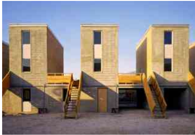
Ilustración 62. Vista frontal del conjunto de viviendas. Obtenida de: http://www.archdaily.mx/mx/02-2794/quinta-monroy-elemental/50102df128ba0d4222000ff7-quinta-monroy-elemental-image
