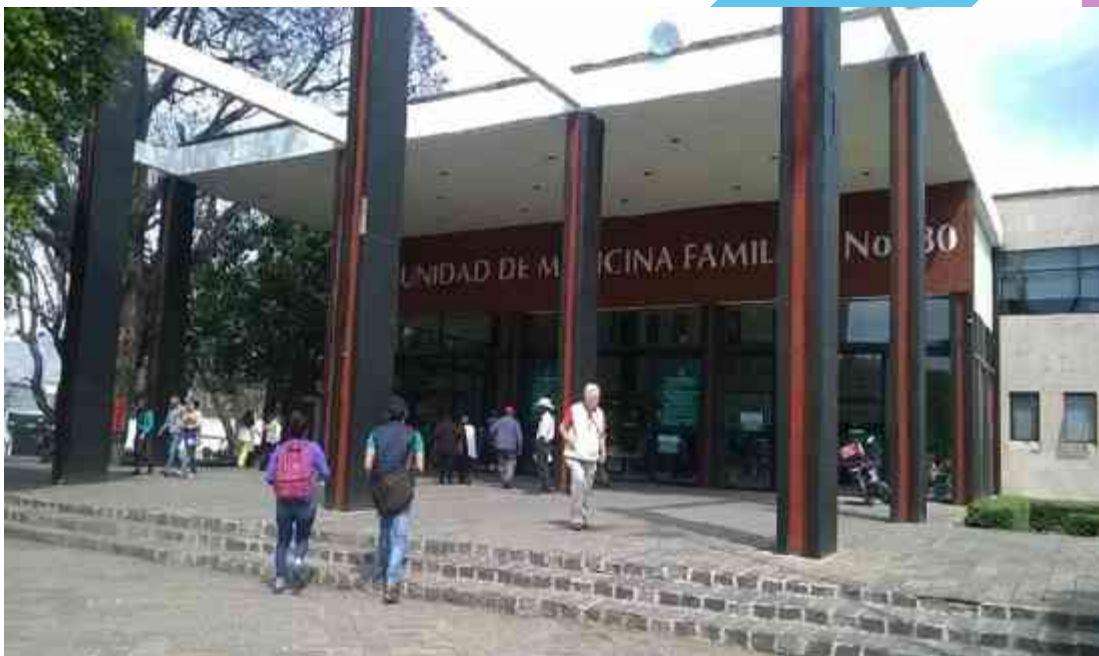
Imagen 23: Entrada principal a base de columnas de concreto y muros cortinas al entrar. Fuente: Flor Itzel S.A
