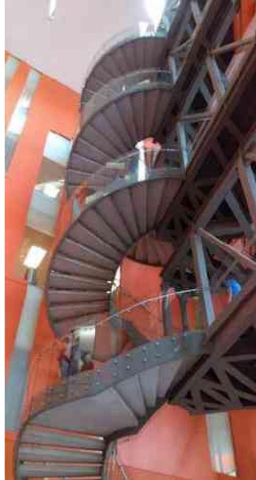
Imagen 29: Escalas del interior de acero y cristal en barandales, con estructura de vigas. Flor Itzel S
