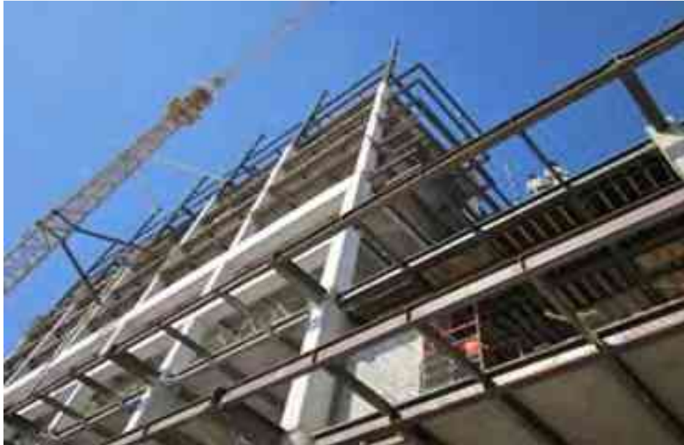
Ilustración 54. Columnas y vigas de acero en obra. Imagen: [http://construmetales-ga.webnode.es/album/nuestro-trabajo/vigas-y-columnas-de-acero-jpg/ FECHA DE CONSULTA OCT/2016]
