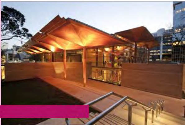
Ilustración 24. Vista trasera de TE ORO. Imagen: [ http://www.archdaily.com/794648/te-oro-archimedia , FECHA DE CONSULTA SEP/2016]
